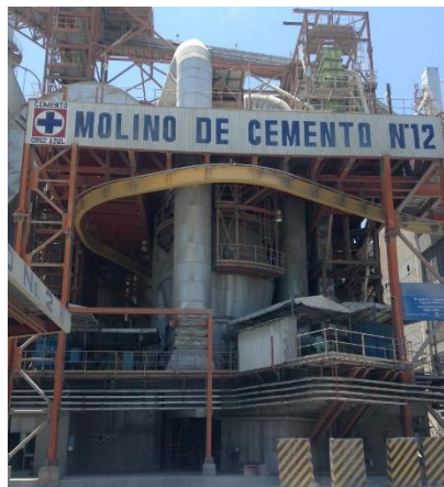
IMAGEN 4.13.3.3. MOLINO DE CEMENTO VERTICAL NO. 12
