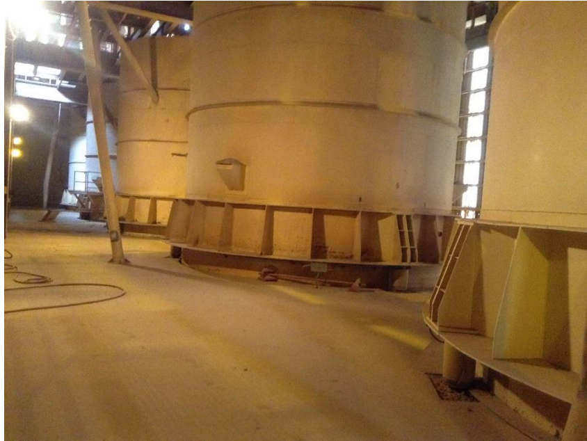
IMAGEN 4.7.3.1. TOLVAS DE ALMACENAMIENTO MATERIAS PRIMAS.
