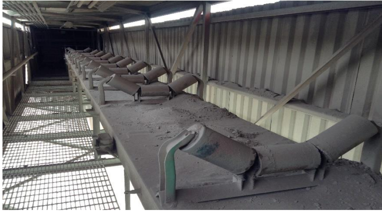
IMAGEN 7.3.6. BANDA TRANSPORTADORA NO.11 EN DESUSO.
