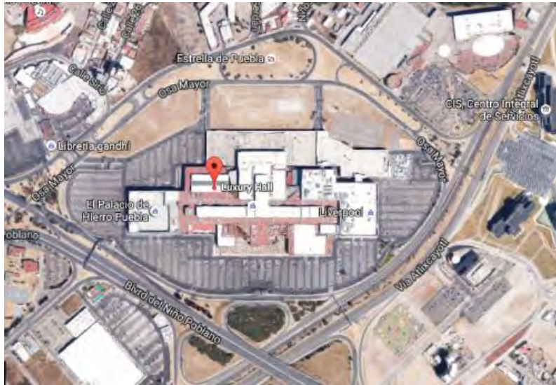
Vista del conjunto, centro comercial Luxury Hall con edificios de diversas tiendas.
