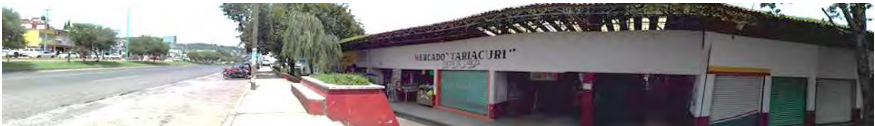
Estado actual del mercado Tariacuri sin funcionar correctamente al estar ubicado en el libramiento del Municipio, frente a la central de Autobuses.
