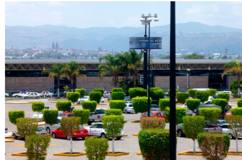
Vista panorámica de la terminal de autobuses TAM
