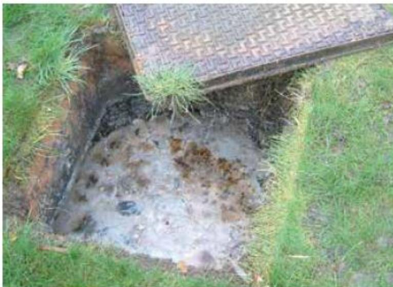
Figura 4: Bola de grasa generada por el desecho de aceite en el alcantarillado
