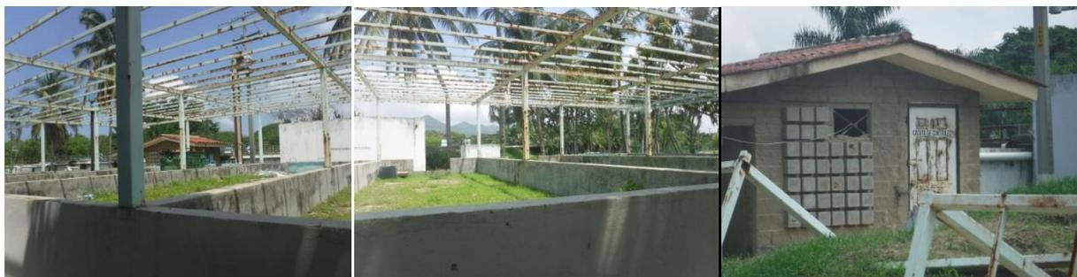
Figura 18. Las primeras dos imágenes son la infraestructura para el pretratamiento de aguas residuales que lucen completamente abandonadas pues están vacías y el pasto ha crecido en esta. La tercera imagen es la caseta de controles en estado inutilizable. Fuente propia, 2017.
