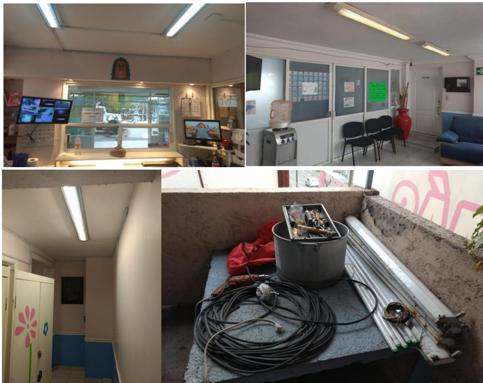
Figura 5.2 Reemplazo de luminarias al interior de la Clínica de Especialidades
