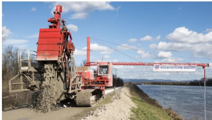
**Figura 5.5e** Herramienta Trench – Mix® realizando una pantalla impermeable a la orilla de un cuerpo de agua.
