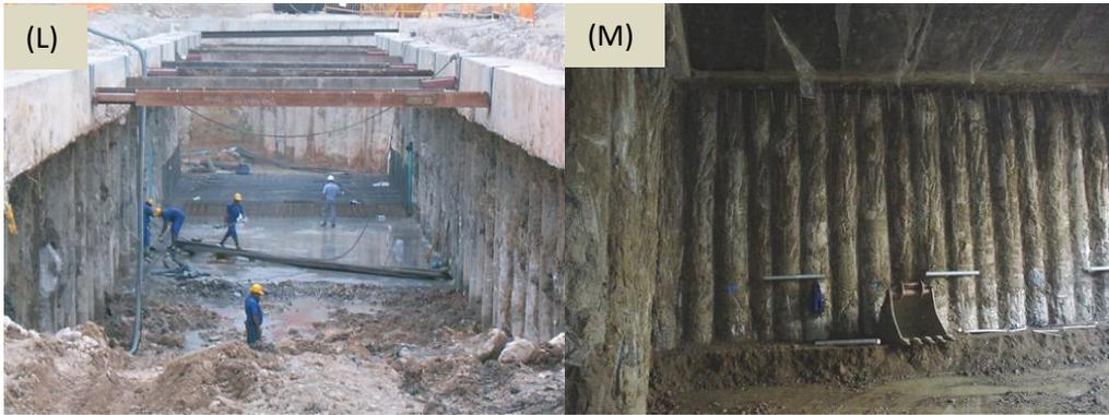
Figura 3.2.1f – (L) “Cut and Cover” para la construcción de túneles carreteros urbanos con pilas secantes y troqueles, (M) Cut and Cover” para la construcción de túneles carreteros urbanos con pilas secantes, excavado una vez colocada la losa tapa.
