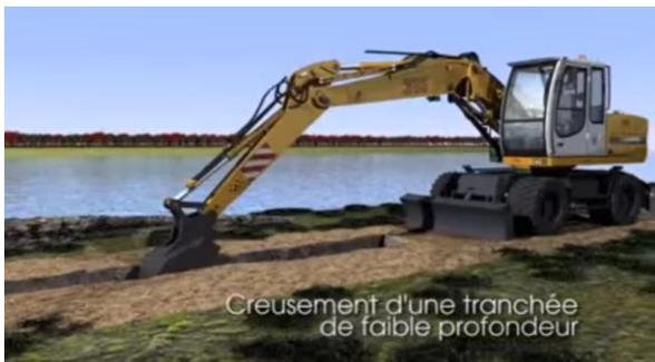
Figura 5.5.a Excavación de zanja guía con excavadora
