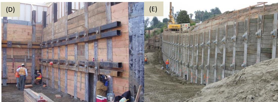
Figura 3.2.1b – (D) “Cut and Cover” para la construcción de estaciones subterráneas por medio de muro Berlín anclado, (E) “Cut and Cover” para construir pasos a desnivel en autopistas por medio de Muro Berlín anclado.
