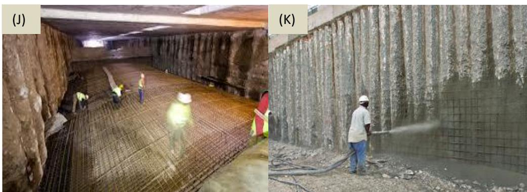
Figura 3.2.1e – (J) “Cut and Cover” para la construcción de túneles carreteros urbanos con pilas secantes, (K) Cut and Cover” para la construcción de túneles carreteros urbanos con pilas secantes y concreto lanzado reforzado.
