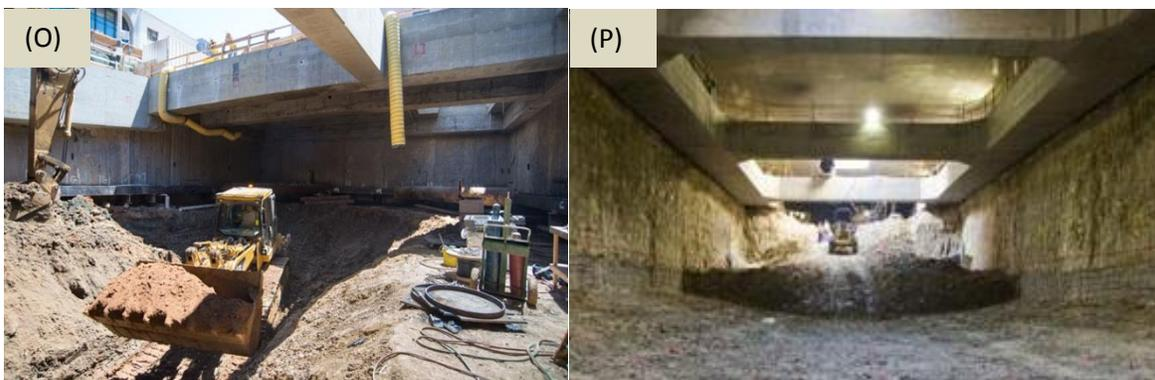
Figura 3.2.1h – (O-P) “Cut and Cover” para la construcción de estaciones subterráneas del metro con muro Milán y traves de concreto fungiendo como troqueles.
