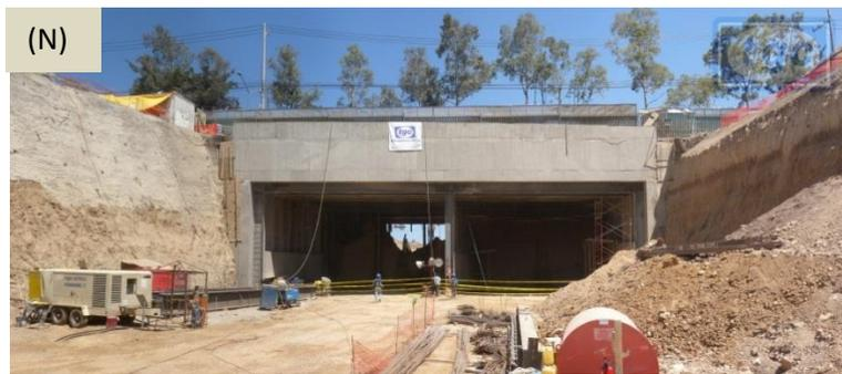
Figura 3.2.1g – (N) “Cut and Cover” para la construcción de desniveles urbanos con pilas secantes y troqueles.
