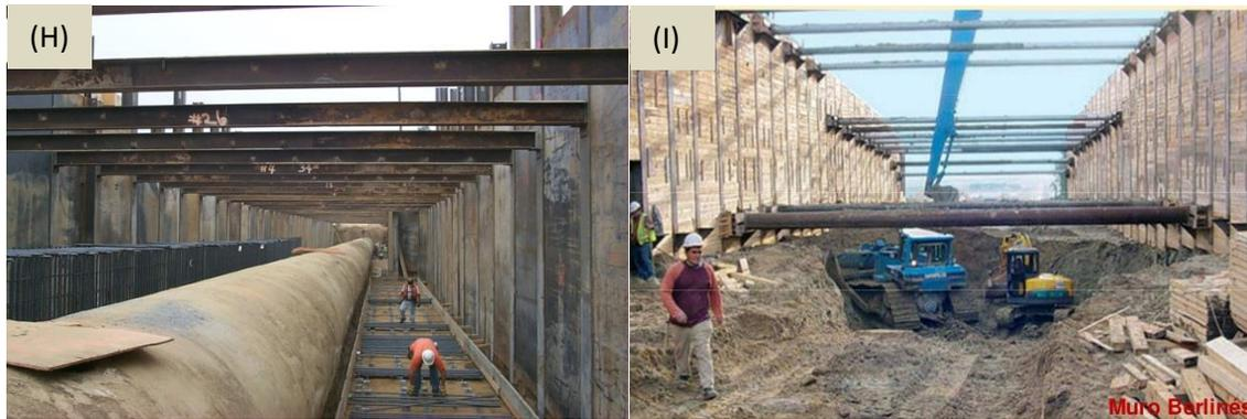
Figura 3.2.1d – (H) “Cut and Cover” para la construcción de túneles de transporte de agua potable por medio de tuberías con largueros de concreto entre los perfiles IR y troqueles, (I) “Cut and Cover” para la construcción de portales de túneles con muro Berlín y troqueles.
