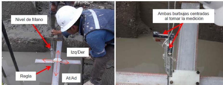
**Figura 5.3.1.2b** Regletas en forma transversal al brocal con nivel de burbuja en ambos sentidos.
