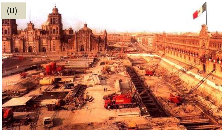
Figura 3.2.1k – (U) “Cut and Cover” para la construcción de algunas estaciones subterráneas de la Cd. De México.
