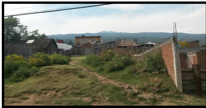
Imagen 3.8.- Diferencia de nivel con respecto a la construcción aledaña
