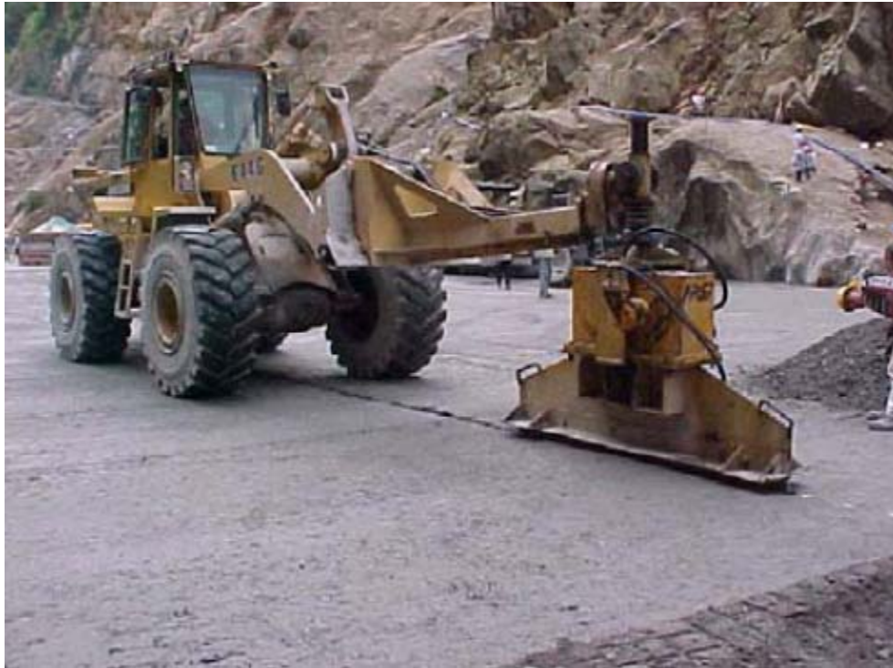
Figura 4- 15 Hincado de lámina para formar la junta de contracción
