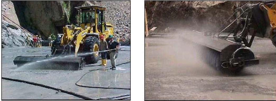
Figura 4- 17 Tratamientos para junta tipo II
