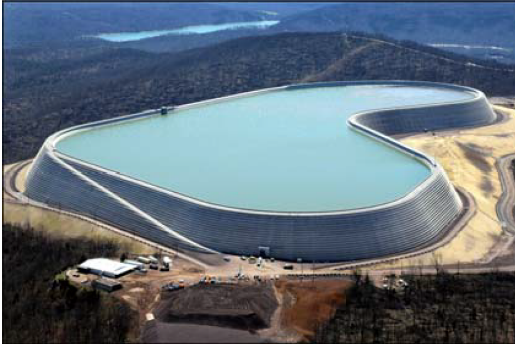
Figura 1- 13 Taum Sauk Upper Dam- Rehabilitada con CCR (Rizzo C., 2008)
