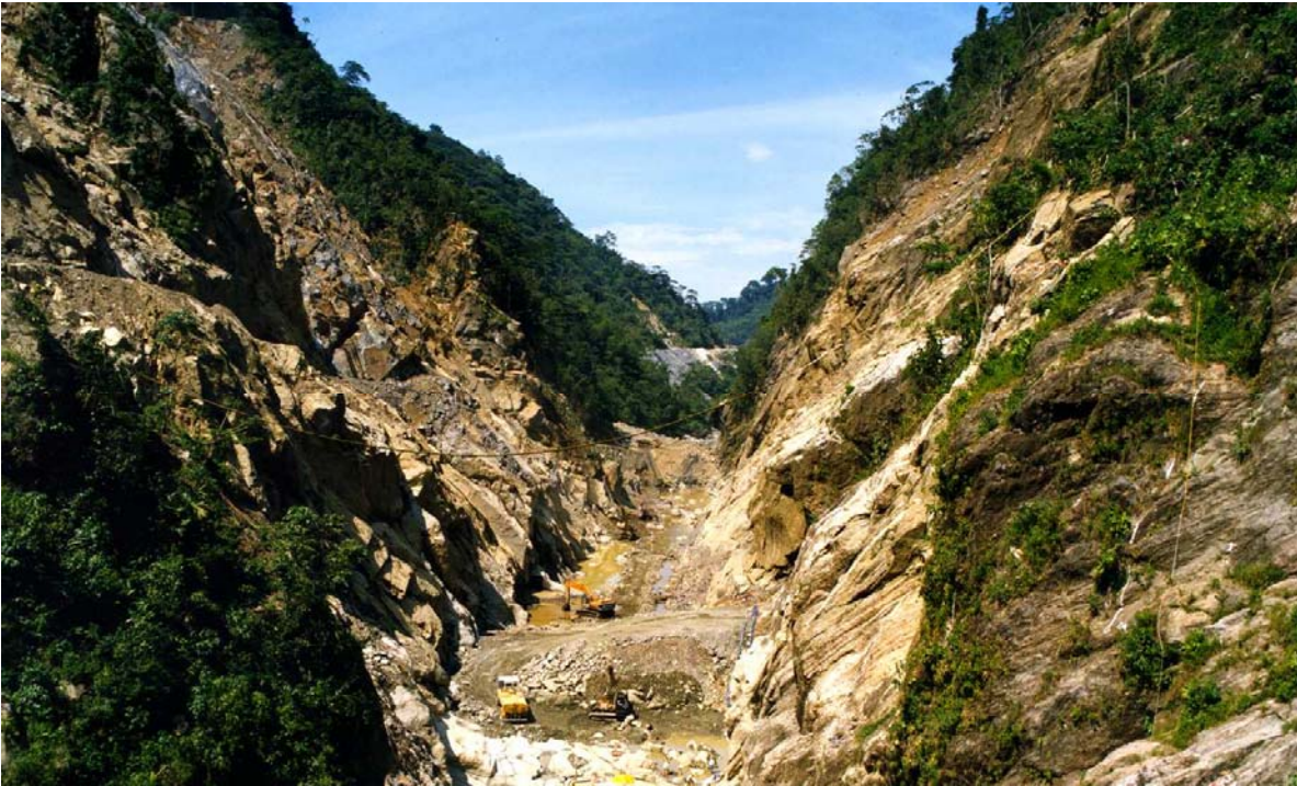
Figura 4- 10 Limpieza en cauce y estribos
