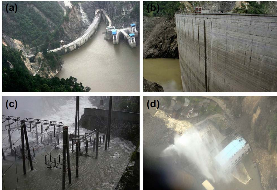
Figura 1- 19 Presa Shapai: a) Presa y obra de toma después del sismo de Wenchuan; b) No se observaron grietas en la presa después de vaciar el embalse; c) la subestación fue inundada; d) Tubería a presión fracturada y casa de máquinas inundada.
