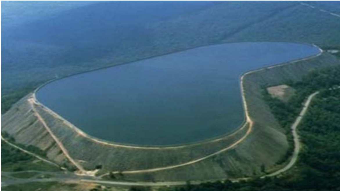
Figura 1- 11 Taum Sauk Upper Reservoir Plant- Antes de la falla (Rizzo C., 2008)
