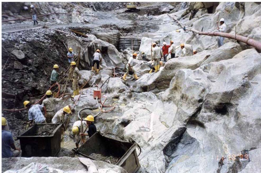
Figura 4- 9 Limpieza en el cauce de la presa
