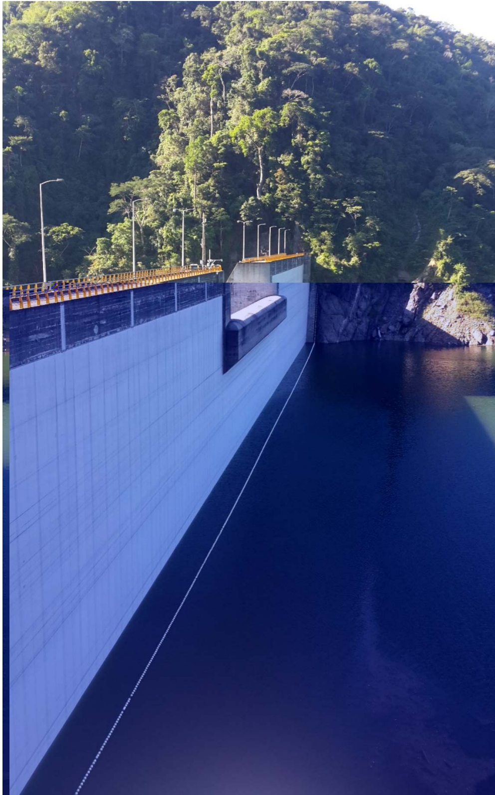
Figura 4- 2 Vista del paramento de la presa desde aguas arriba- Margen derecha
