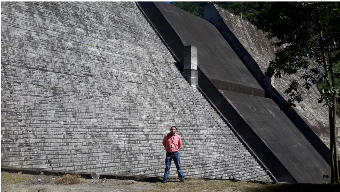
Figura 4- 3 Vista del vertedor aguas abajo desde margen derecha
