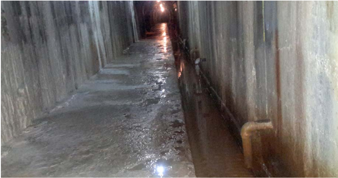
Figura 4- 24 Descarga de tuberías dentro de galería
