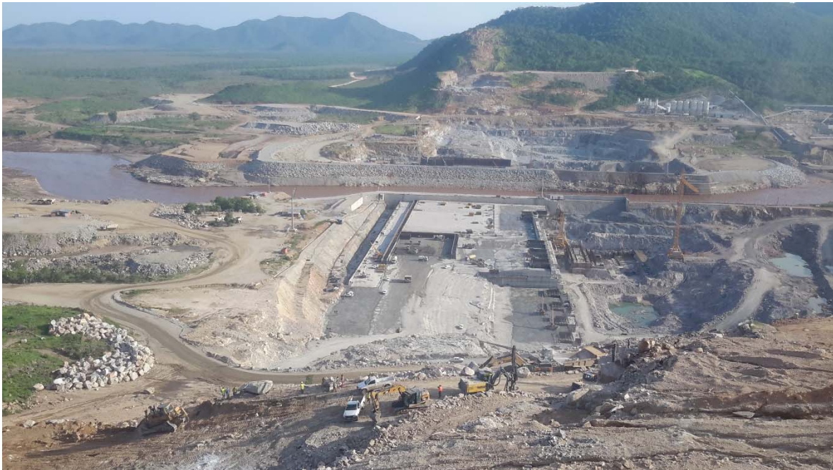
Figura 4- 43 Vista desde margen izquierda hacia margen derecha
