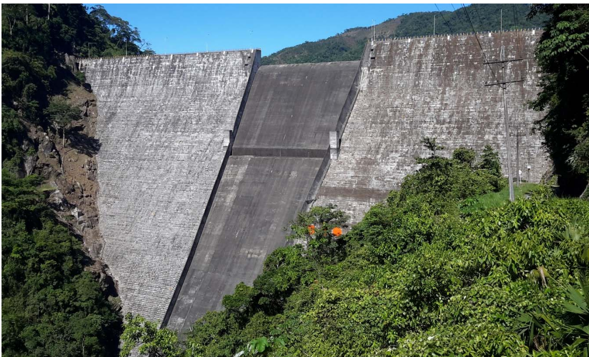
Figura 4- 1 Vista aguas abajo de la presa Miel I
