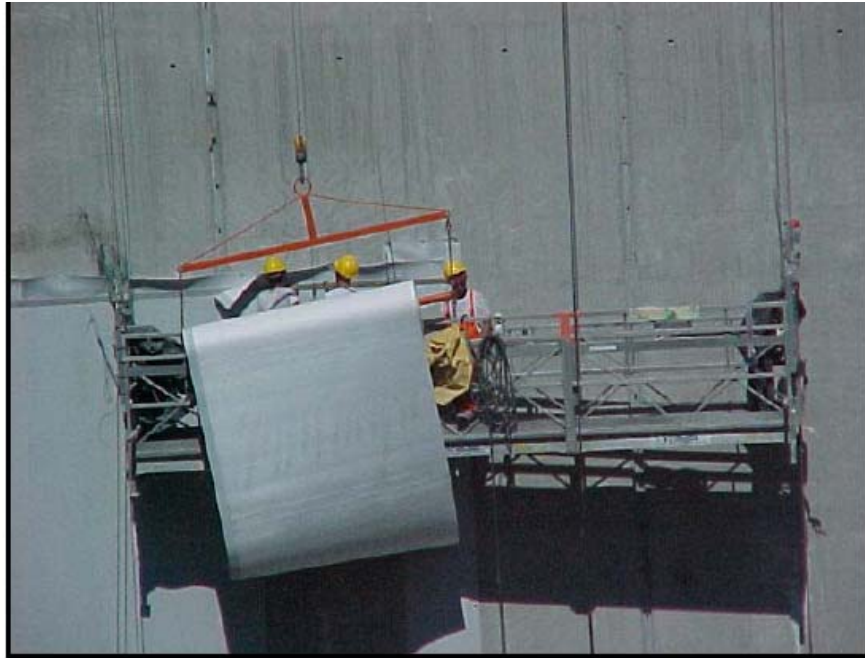
Figura 4- 19 Tendido de rollos de membrana en la cara frontal de la presa
