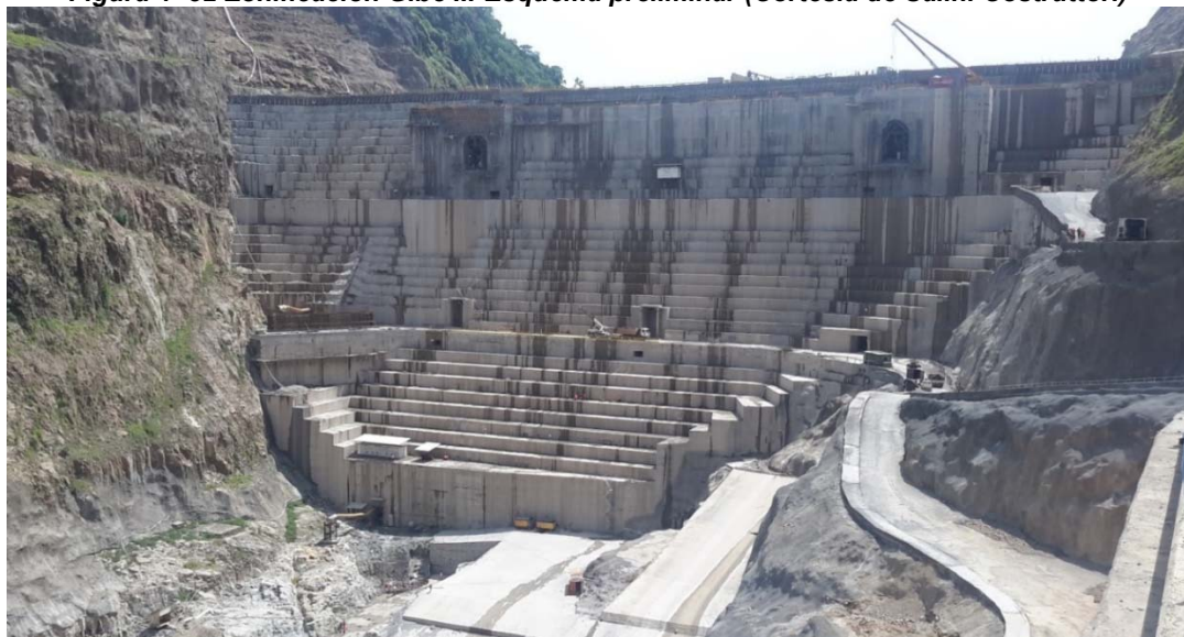
Figura 4- 33 Vista desde aguas abajo
