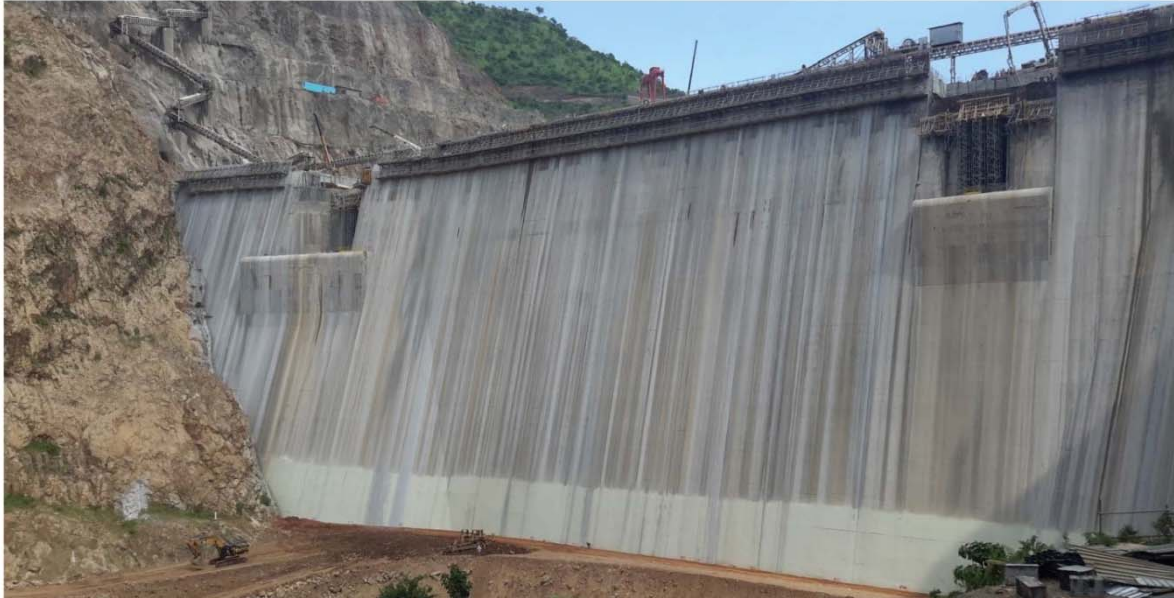
Figura 4- 38 Vista aguas arriba- Se observa membrana colocada mediante aspersión
