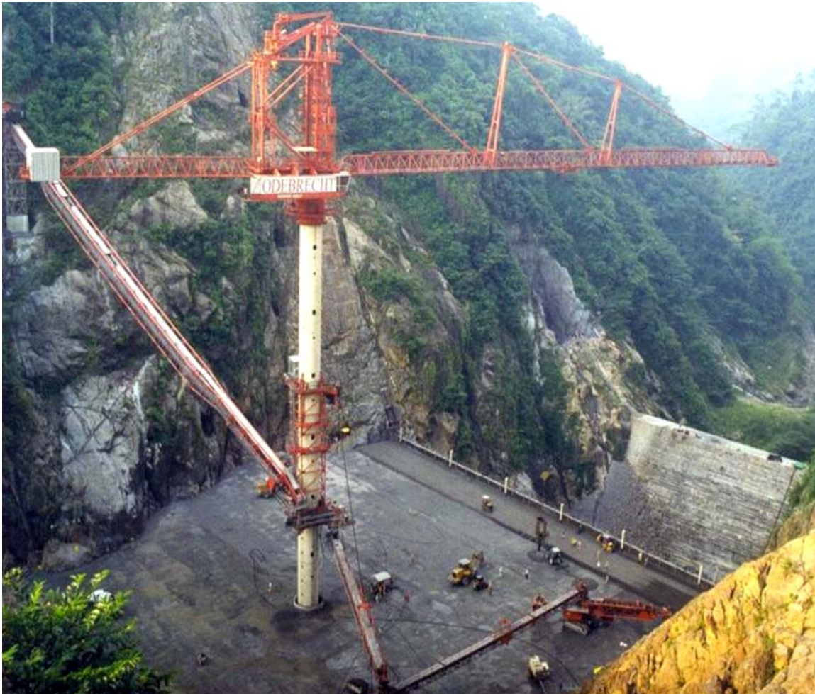
Figura 4- 13 Colocación de CCR mediante Tower Crane
