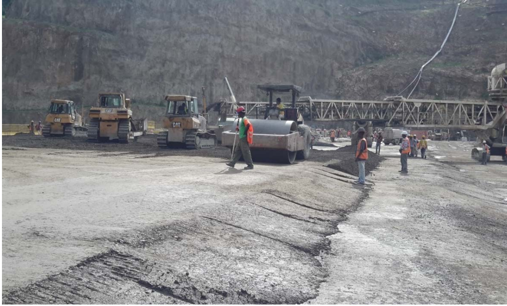
Figura 4- 35 Extendido y compactación de CCR
