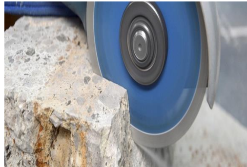
Imagen 2. Corte concreto con disco de diamante.
