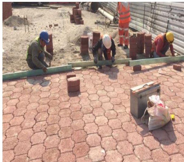
Ilustración 21. Colocación de adoquín, fotografía tomada por el autor, 2017.
