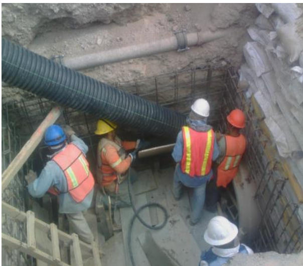
Ilustración 20. Colado de losa de fondo y primer trepado de muros perimetrales en caja, fotografía tomada por el autor, 2017.
