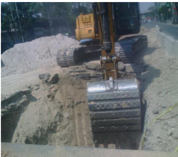
Ilustración 14. Excavación de zanja, Espíndola A. 2017.
