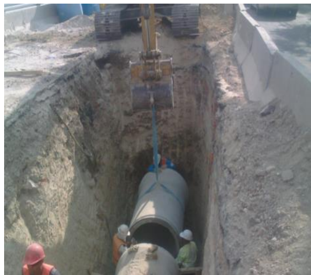
Ilustración 15. Colocación de tubería de concreto reforzado, posterior a la colocación de cama de arena, Espíndola A. 2017.
