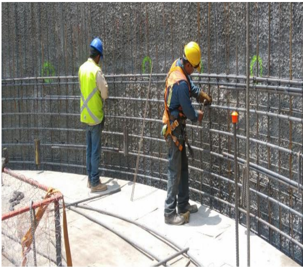
Ilustración 18 Armado para revestimiento definitivo de lumbrera, Castellanos M. 2017.
