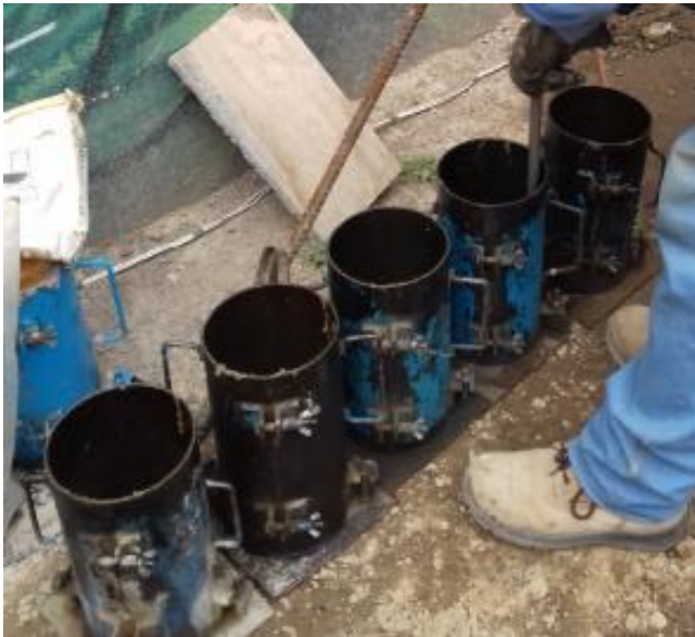
Ilustración 26. Muestreo de cilindros para verificar resistencia de concreto, fotografía tomada por el autor, 2017.
