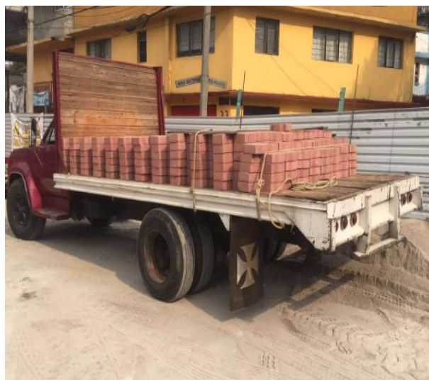
Ilustración 23. Suministro de adoquín, fotografía tomada por el autor, 2017.
