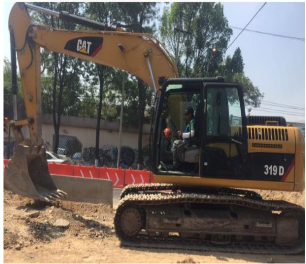
Ilustración 7. Retroexcavadora CAT 319 D fotografía tomada por el autor, 2017.
