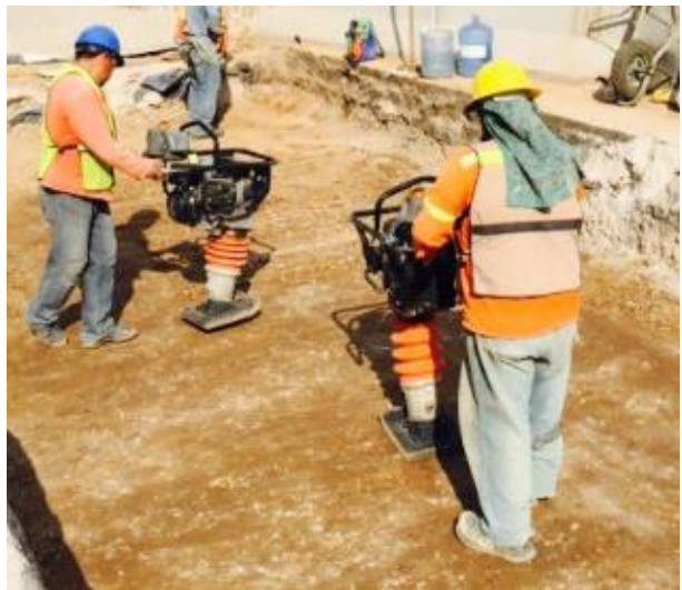
Ilustración 9. Compactador manual, tipo bailarina, fotografía tomada por el autor, 2017.
