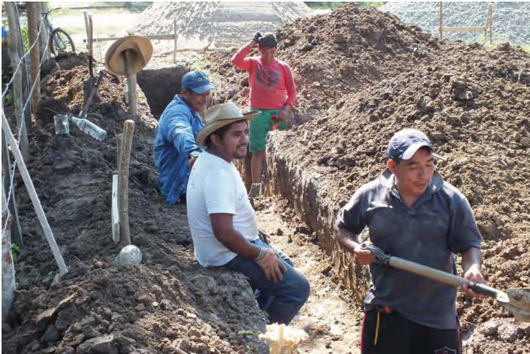
“Algunos tamborileros trabajando en el oficio de albañilería” Foto: Manuel Alejandro López Jiménez. Mayo, 2013.
