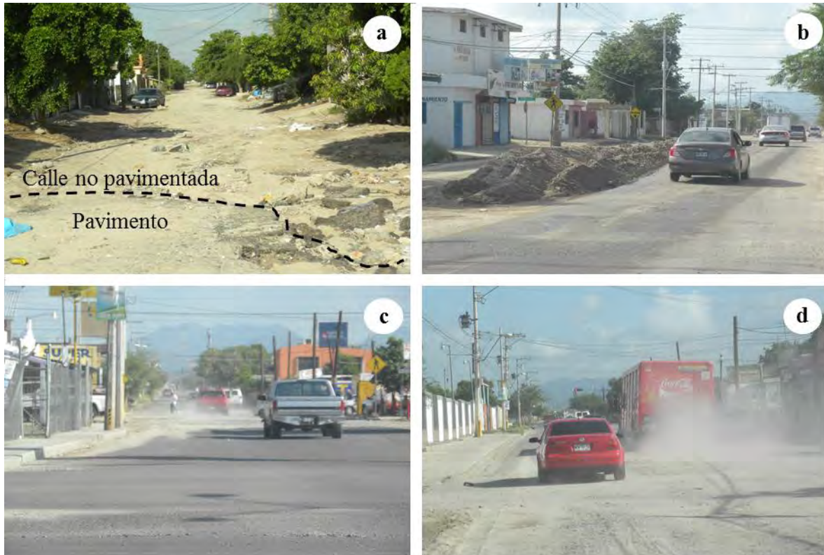
Figura 5. 10 Imágenes de calles de Hermosillo en el comienzo del post-monzón. a) Fuertes procesos de erosión en calles no pavimentadas de orientación E-W durante las lluvias del Monzón Norteamericano; b) Acumulación de material en calles pavimentadas, procedente de la erosión de calles sin pavimentar. c) y d) Fenómenos de re-suspensión de polvo depositado en calles de Hermosillo, polvo fugitivo producido por el tráfico rodado.
