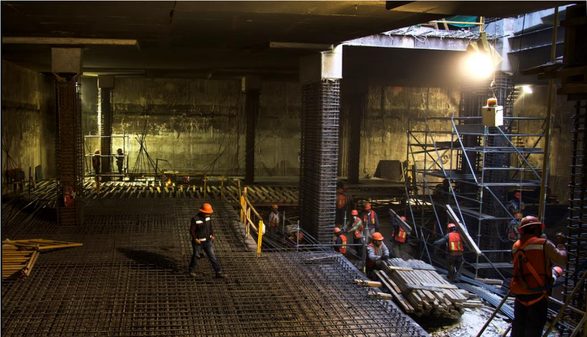
Figura 3 Ejecución de proyecto Insurgentes 700 con método de Top-Down (CIMESA, 2017)
