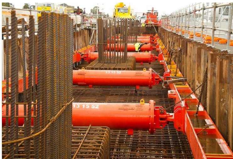
Figura 1 Uso de precarga en excavaciones. (Honvajec, Joseph. 2015)
