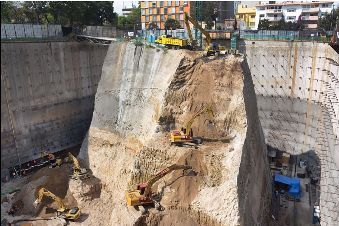
Figura 5 Excavación a cielo abierto estabilizada con anclas. Proyecto Manacar. (CIMESA, 2015).
