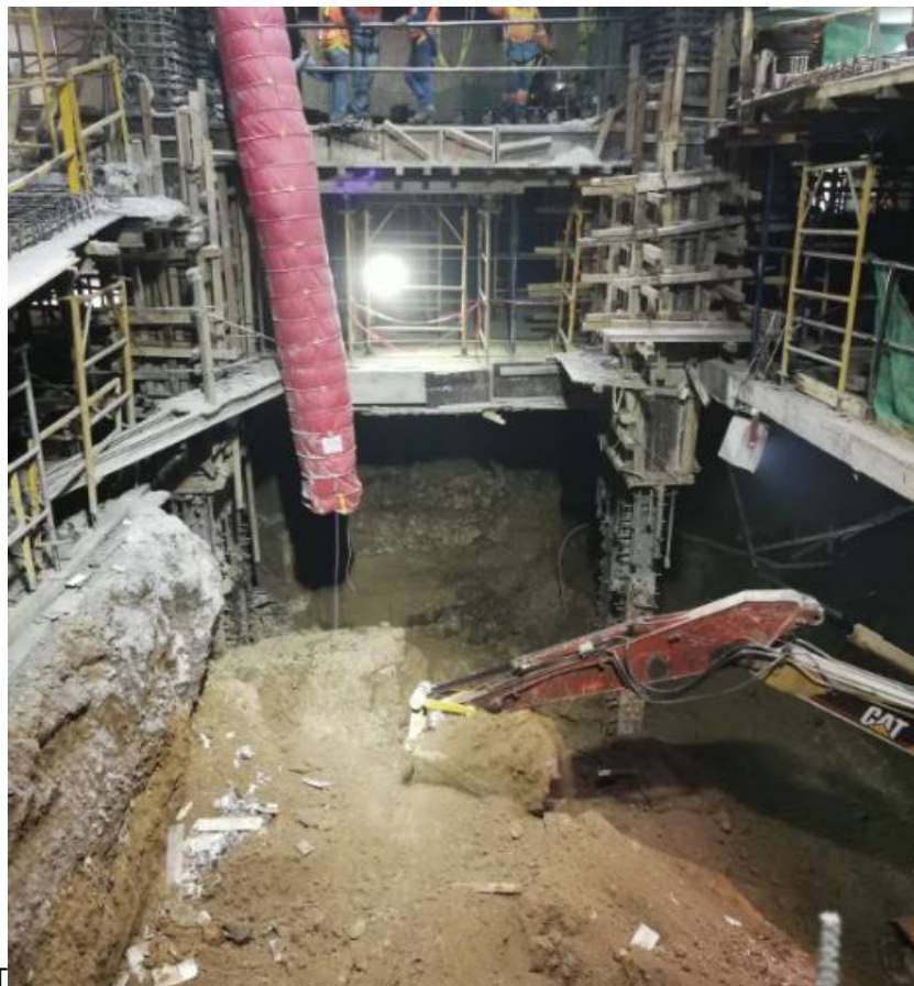
Figura 4 Ejecución de proyecto Insurgentes 700 con método de Top-Down (CIMESA, 2017)
