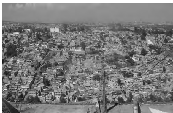
31. Viviendas en zona de alto riesgo / Suelo colapsable. Delegación Magdalena Contreras, Colonia La Carbonera.
