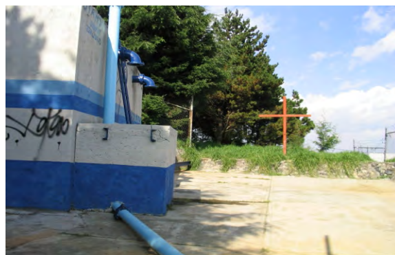
(Foto 1). Foto del Tanque "Las Creces" Zona de estudio,
