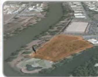
FOTOGRAFÍA AÉREA SUR
