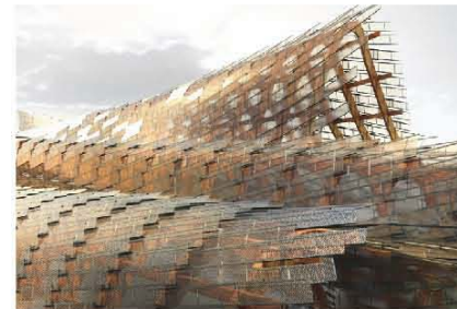
Cubierta flotante del Pabellón paneles de bambú colocados sobre vigas de madera elevadas, en paralelo a la tradicional construcción china.
