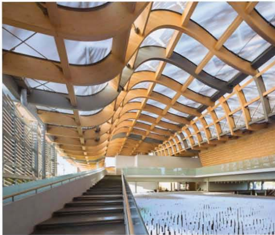
Escalera principal de Pabellón con detalle de cubierta, vigas de madera con paneles de bambú, cubren la parte temática, campo de trigo.
