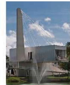
La estructura está reforzada con tensores sujetos a una gran columna de concreto. El volado del mirador tiene más de 13 metros de largo.
