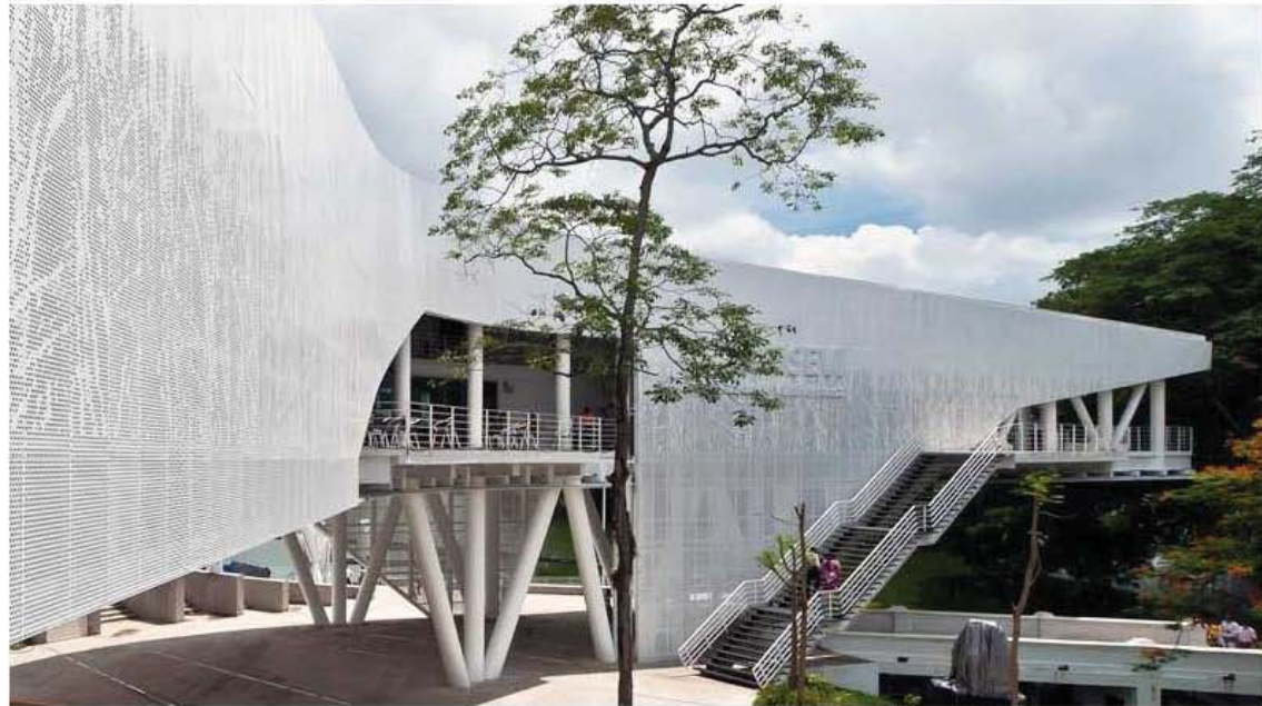
El edificio cumple la función de conectar a modo de puente peatonal las dos secciones de La Laguna de las Ilusiones, un cuerpo de agua muy importante integrado a la ciudad. La estructura del edificio está compuesta principalmente de una gran armadura de acero que delimita el contorno del edificio. Fotografía rescatada de: http://www.archdaily.mx/mx/02-101277/musevi-ten-arquitectos
