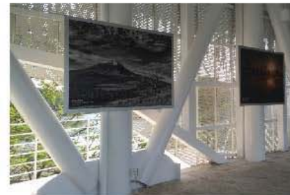
La estructura del edificio está compuesta por una armadura perimetral la cual está cubierta por una celosía que ayuda a regular la temperatura e incidencia de luz al interior.
