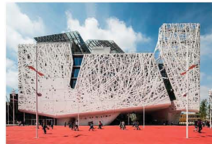
Fachada Este del edificio, fachada que da frente al corredor principal de la Expo Milán 2015, a la cual este edificio pertenece como único elemento permanente.
