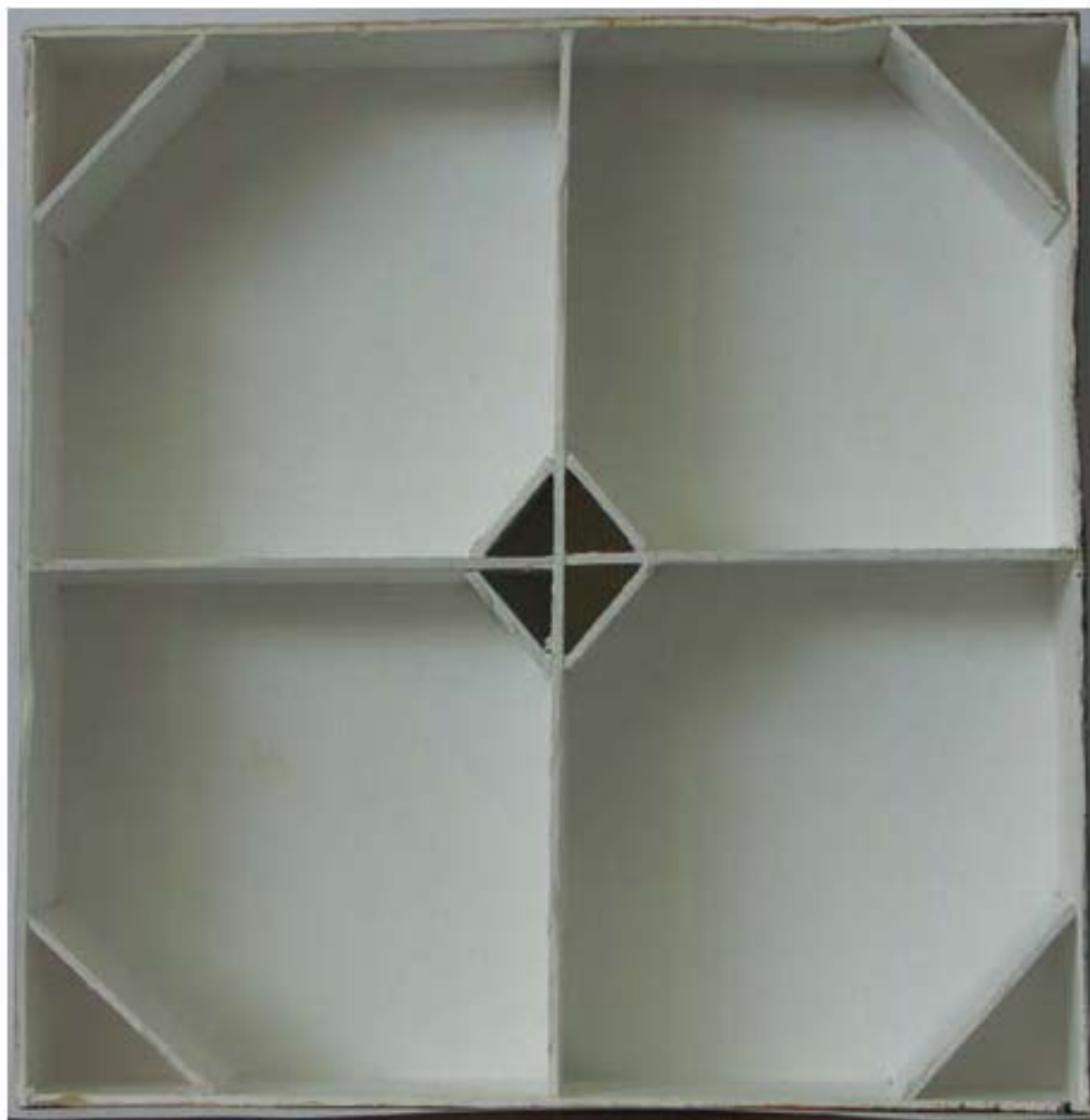
Estructura posterior del bastidor construido con cartón batería, 40 x 40 cm.
