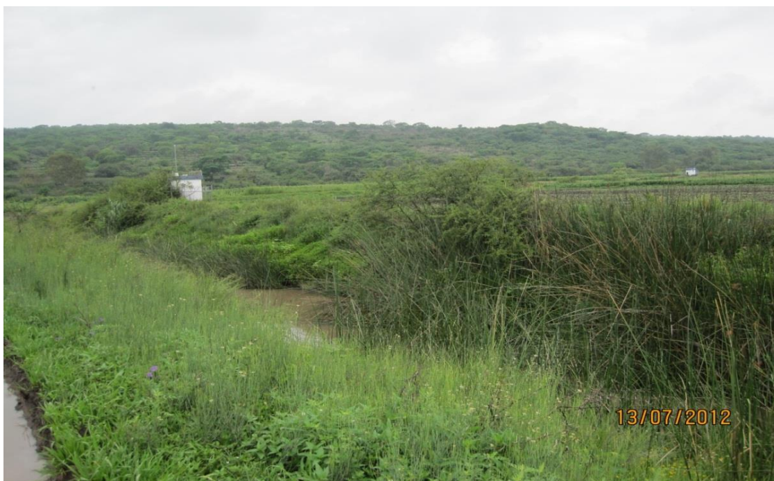
Figura 41. Canal de Riego infestado de Maleza Acuática. Módulo Valle
