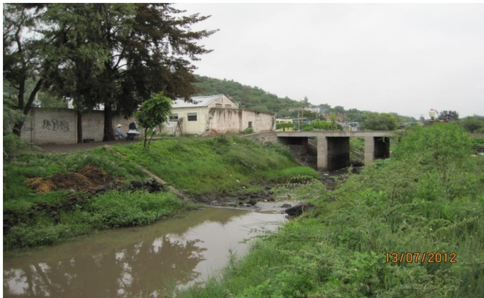
Figura 40. Canal sin revestir del Módulo Valle
