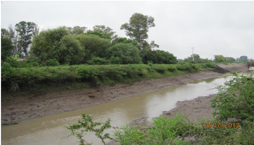
Fotografía 3. Canales sin Revestir
