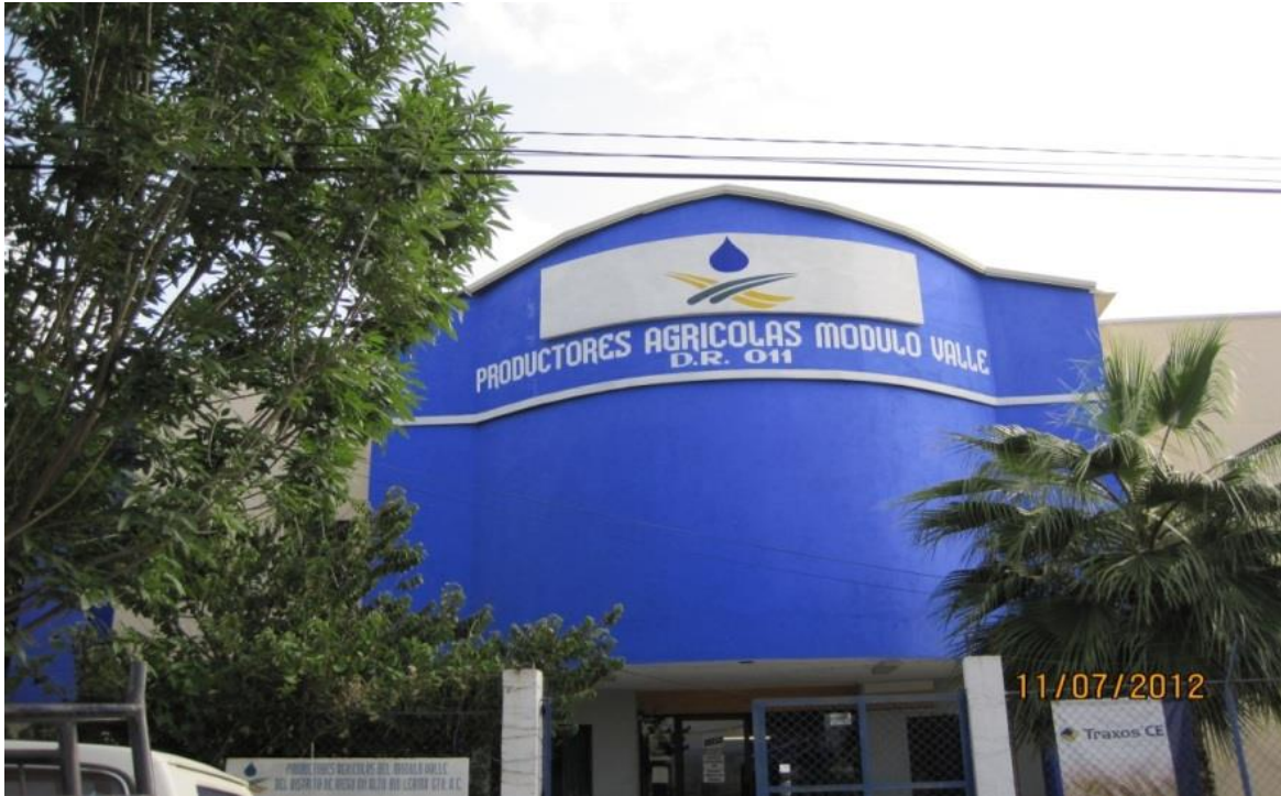
Figura 23. Oficinas del Módulo de Riego 04, Valle de Santiago
