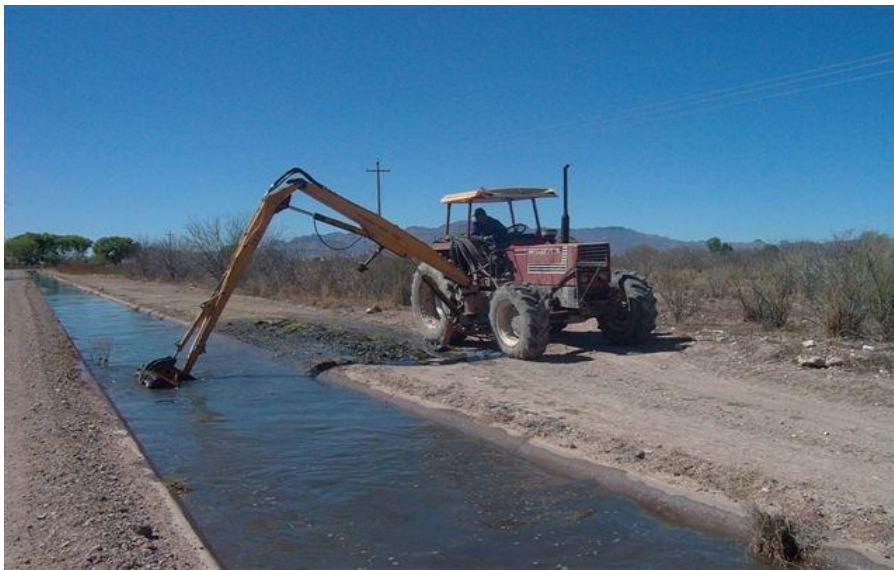
Figura 15. Desazolve de Canales.
