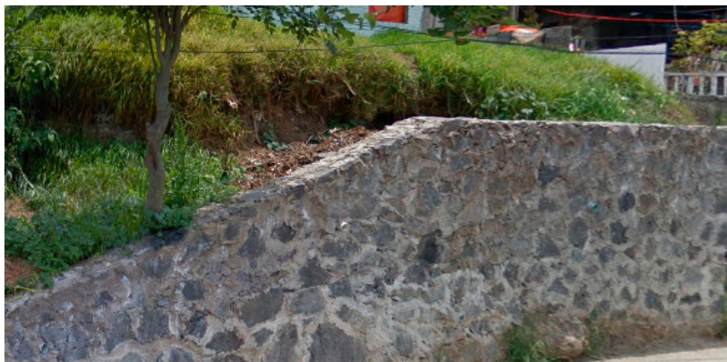
143. Muro de contención de piedra braza
