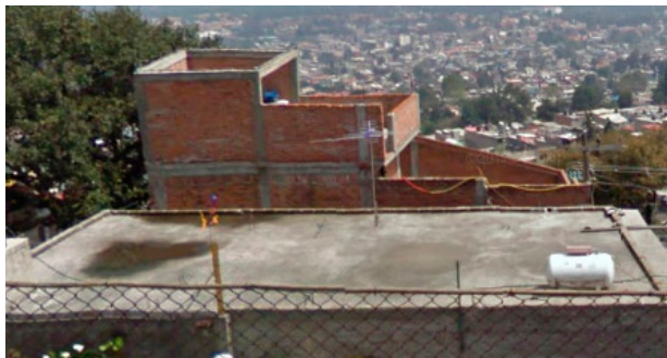
202. Losa plana de concreto armado
