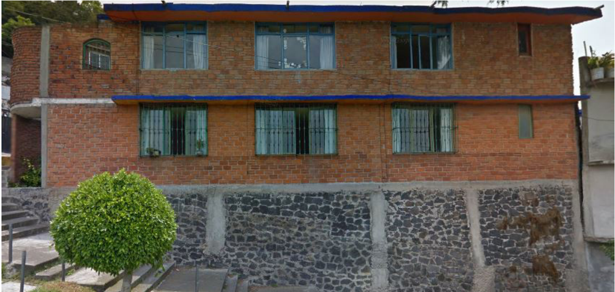
97. Vivienda de dos niveles con cimentación de mampostería. Imagen de Google Maps, Street View
