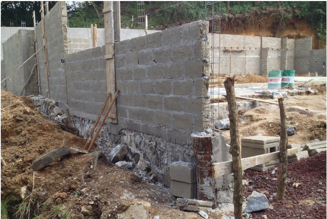
39. Fotografía de una cimentación en obra
