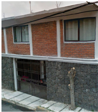
107. Muros de piedra braza
