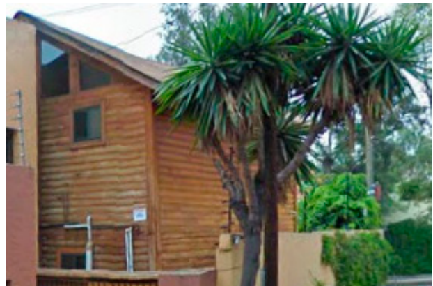
332. Instalación de agua al exterior de la vivienda
