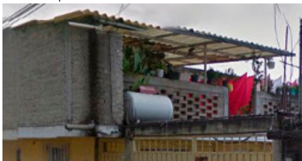
203.. Láminas de plástico con estructuras metálicas
