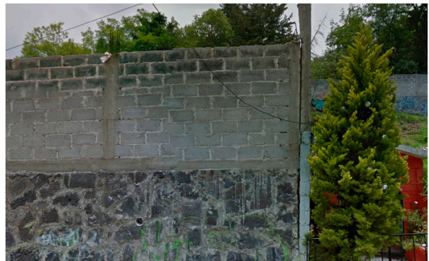
110. Muros de contención de piedra braza
