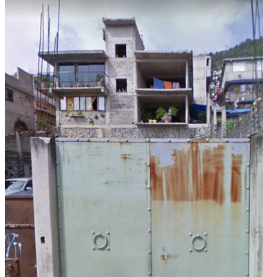
46. Vivienda en obra negra
