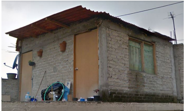
210. Las cubiertas de lámina son una práctica común
