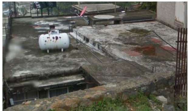
216. Cubierta con acceso desde la banqueta
