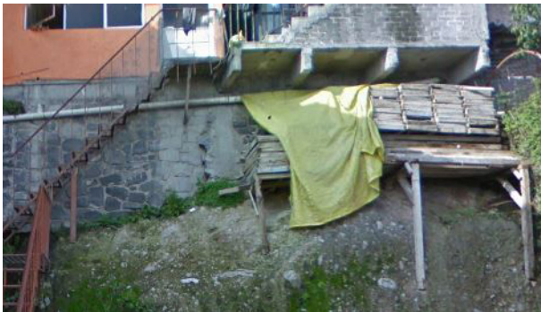
317. Elementos de gran peralte sin ningún tipo de apoyo
