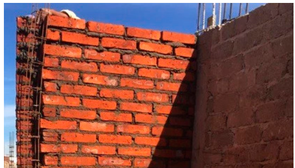
135. Detalle de muro de tabique con armado oculto
