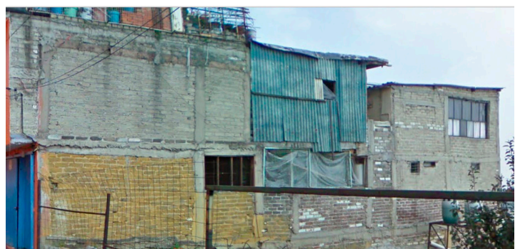
152. Vivienda construida con diferentes tipos de tabicón
