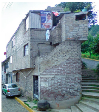
109. Muros de tabicón
