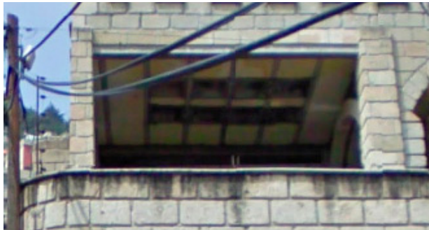
201. Losas con casetones
