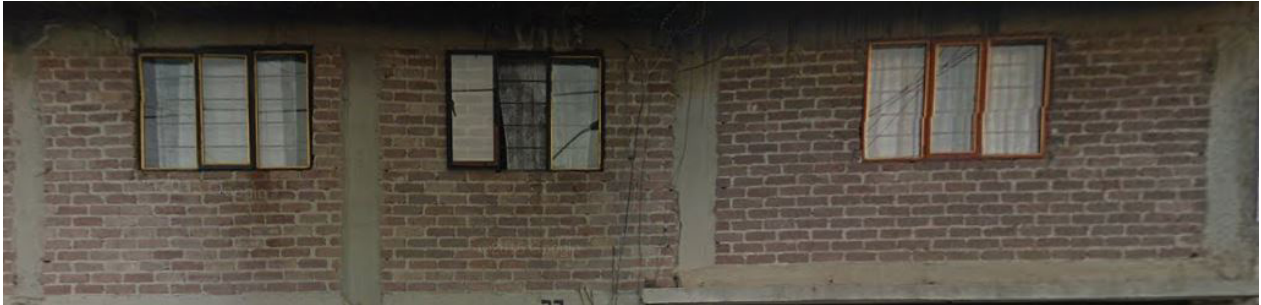
316. Es común que las ventanas se coloquen en el lecho bajo de las cadenas para evitar hacer otro tipo de cerramiento.
