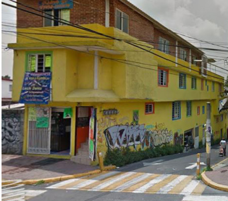
45. Construcción de 4 niveles
