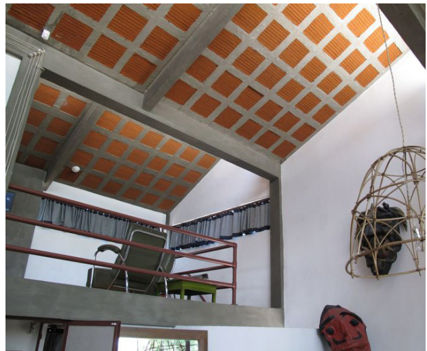
244. Losa reticular o nervada
