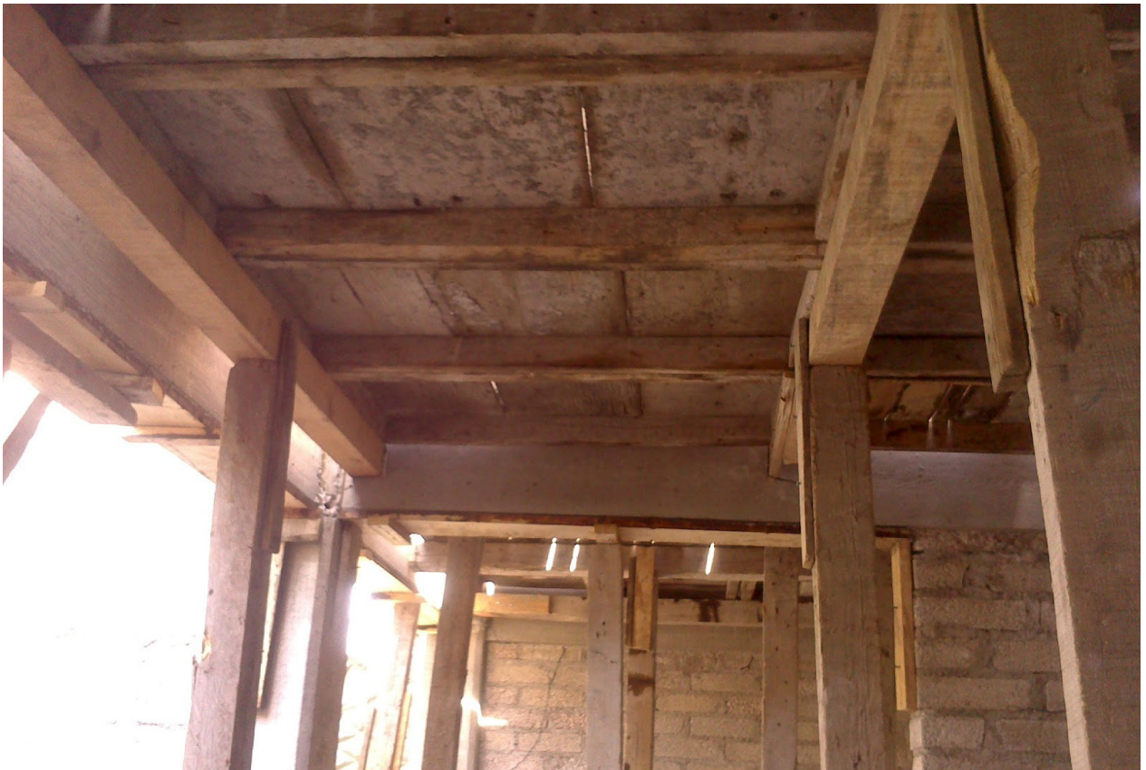
194. Fotografía de apuntalamiento para colado de losa en visita de obra
