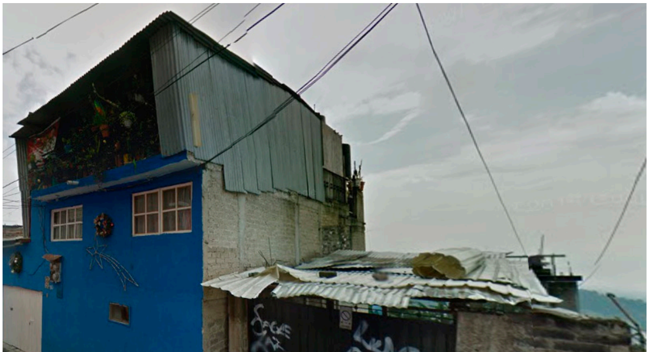
209. Dinámica de construcción con láminas. El material es utilizado como cubierta pero también como “pared”.
