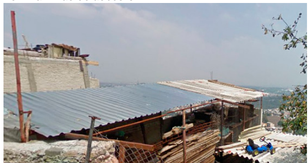
208. Láminas metálicas
