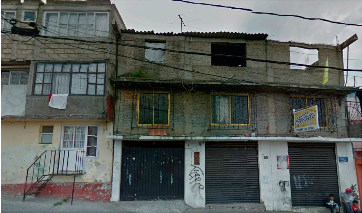
116. Ejemplo del crecimiento por fases de una vivienda en el cual la parte superior resulta en un espacio no habitable.
