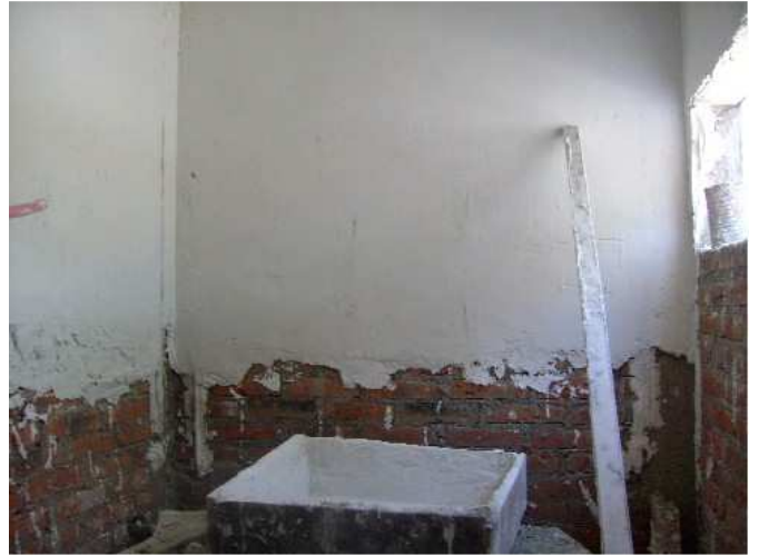
Aplanado de yeso aplicado en muros de tabique, tablaroca o durock
