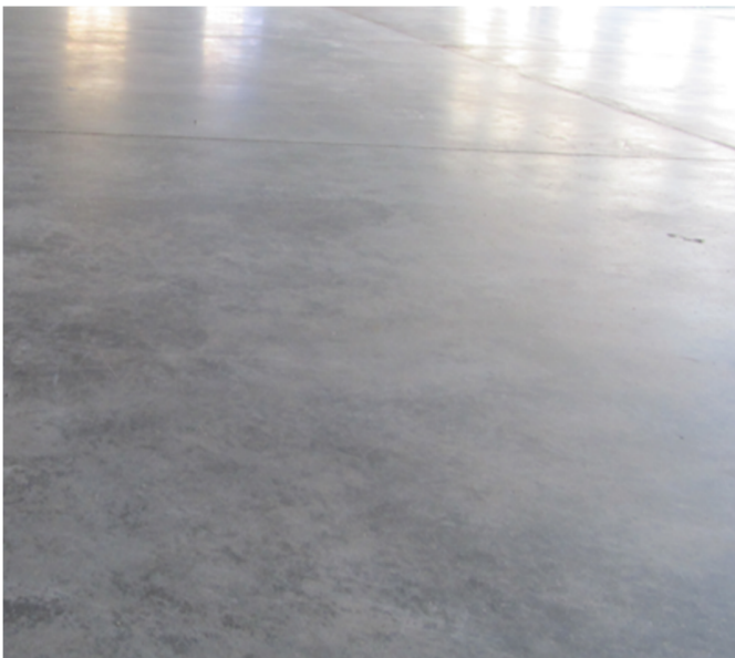
Concreto pulido acabado mate aplicado en pisos
