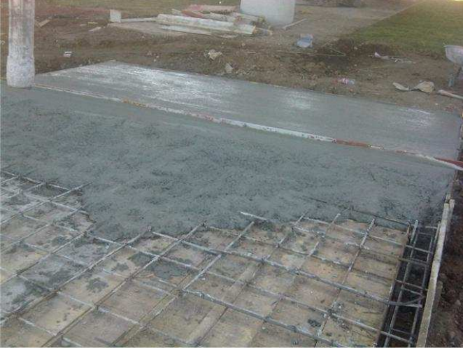
Firme de concreto armado para sótano.
