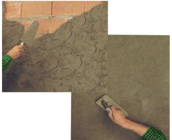
Aplanado de mortero aplicado en muros de tabique, tablaroca o durock
