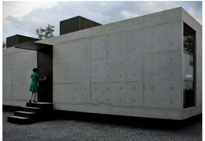
Gráfico 63. Concreto aparente utilizado en fachada. Fuente: (stacion-ARquitectura_1, 2009).
