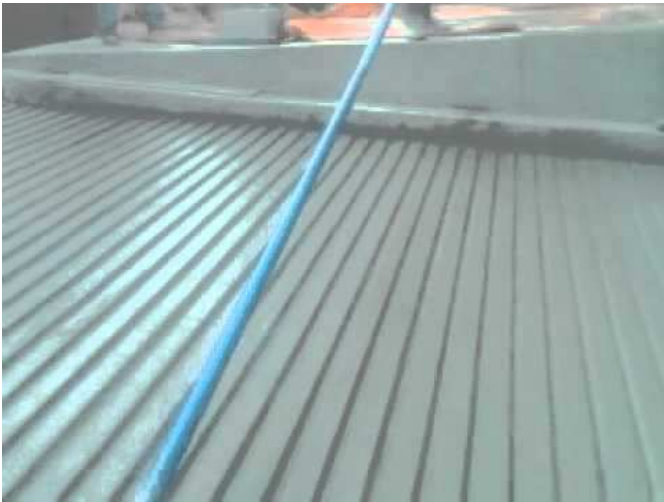
Concreto rayado antiderrapante aplicado rampa de estacionamiento
