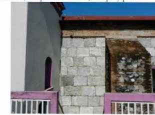
7. Detalle de los materiales utilizados en la obra del templo. Destacan los bloques de mármol de un banco cercano a la comunidad, que no se explotó por ser impuro para su comercio.
