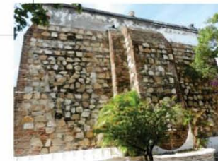
8. Exterior del muro testero. Los templos posteriores a 1550 en la región, llevan un contrafuerte a la mitad del paramento. Es visible el sistema constructivo con encadenamientos de tabique.
