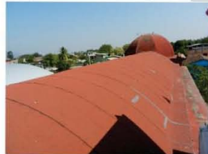
6. Aspecto de la azotea. Una bóveda gallonada cubre al presbiterio y una de cañón corrido a la nave.
