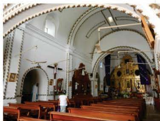
5. El arco toral forma una media luna. Es similar al del templo de Comitancillo. La bóveda de cañón la soportan arcos fajones y pilares adosados. Al fondo el presbiterio.
