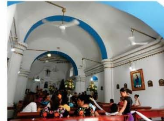
5. El arco toral forma una media luna. Esto es característico de los templos donde el volumen del presbiterio es mas alto que el de la nave. Es posible que indique etapas sucesivas de obra. Lo tienen Comitancillo y Juchitán.
