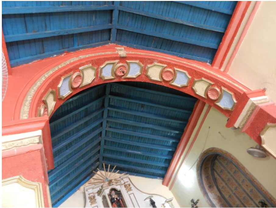
Figura 102. Sistema estructural de cubierta de tejado soportado en arcos fajones de tabique. Vista del tejado del templo de San Pedro Apóstol Huilotepec, Huilotepec en 2016. Foto del autor.
