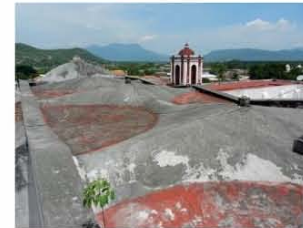
3. Aspecto de la azotea del templo principal. Las bóvedas nervadas fueron restauradas por los Misioneros Oblatos, hacia 1950, lo que permitió el uso del inmueble hasta ahora.
