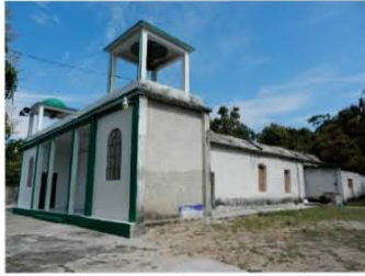
1. Aspecto del templo de Santiago. Se aprecian las diversas intervenciones que ha tenido. En la última, se demolió y amplió el presbiterio y se construyó el pórtico y campanarios.
