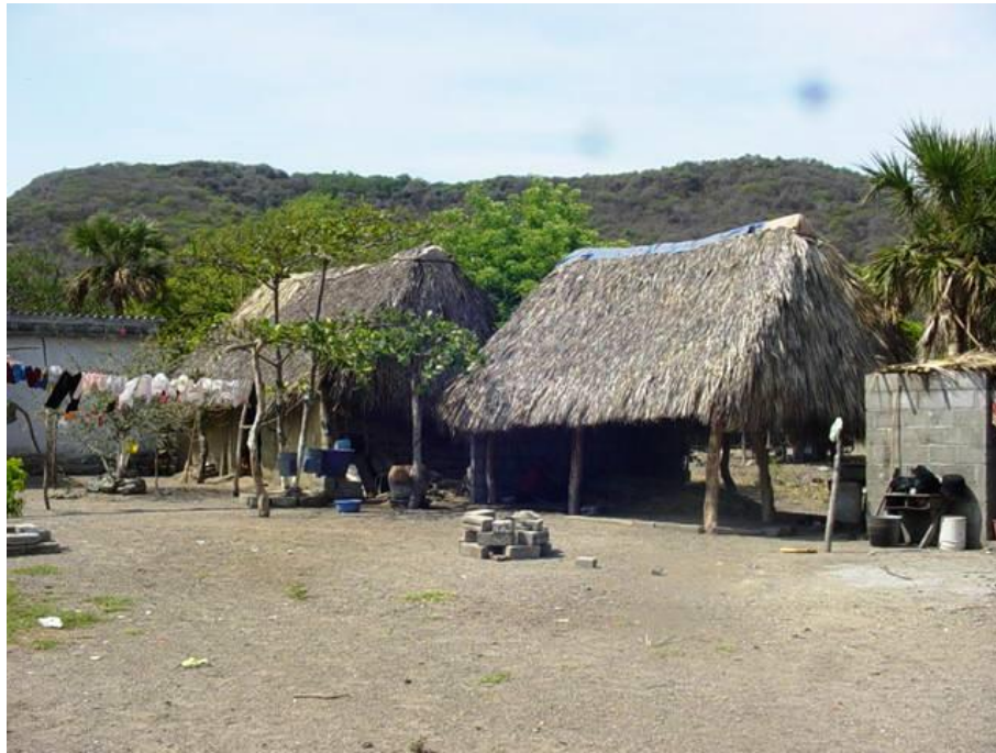
Figura 90. Habitación de lodo y cubierta de palma. Frente a ella se encuentra una enramada a dos aguas. La imagen es de 2006 y muestra una vivienda en San Dionisio del Mar Pueblo Viejo, Oaxaca. Este ejemplo da una idea de cómo fue la iglesia provisional edificada en el Istmo Sur en momentos tempranos de la Colonia. Foto del autor.
