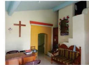
7. La antigua sacristía está modificada. Se le añadieron una oficina y cuartos de habitación. El tejado se sustituyó por una losa de concreto armado.
