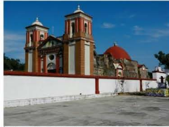
1. El templo visto desde la plaza central del pueblo. Conserva su barda y tres entradas al atrio. Es uno de los inmuebles más grandes del Istmo Sur.
