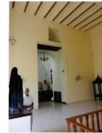
5. Aspecto de una capilla anexa al templo por su costado sur. La cubierta de tejado se sustituyó por una losa de concreto armado.
