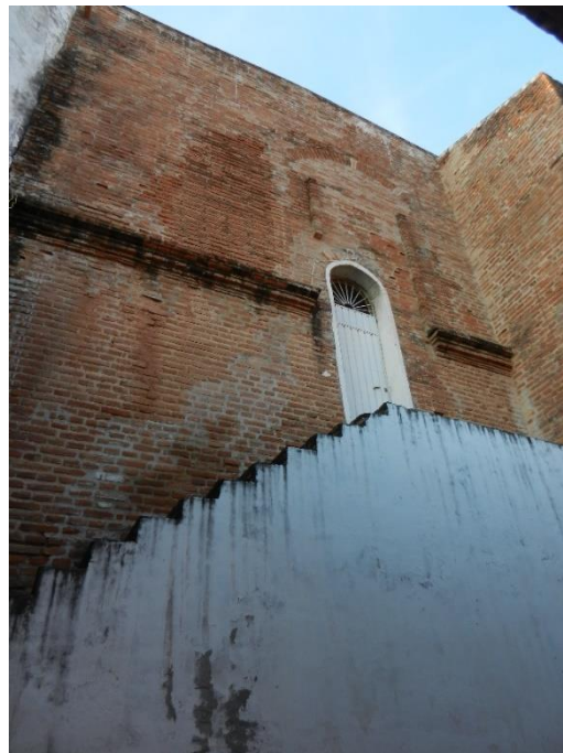
Figura 101. El uso de tabique para construir el convento de Tehuantepec se intensificó hacia 1550. Es notable en la fábrica del claustro, el templo conventual y la capilla de indios. Vista exterior del muro sur del coro de la iglesia del convento de Santo Domingo Tehuantepec en 2016. Foto del autor.
