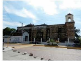
2. Vista de la fachada sur. Se aprecian dos tramos cubiertos con bóvedas vaídas y uno con cañón. Los campanarios se hicieron en la década de 1970.
