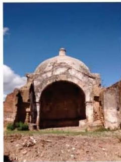
4. La capilla mayor de La Magdalena . Es una estructura construida con muros de piedra y tabique. Lleva contrafuertes en los costados de la fachada, la que se abre en un arco de medio punto. Frente a ella tuvo una enramada.
