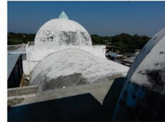
4. El inmueble tiene bóvedas gallonadas en el presbiterio y el coro; en la nave un bóveda de cañón. Esta vista es hacia el norte.
