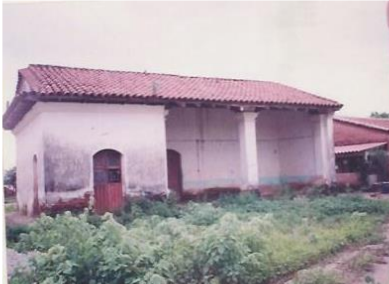
Figura 89. La casa de tabique y cubierta de teja, yoo dexa . En la región del Istmo aún se conserva esta tipología. La imagen es de 2006 y muestra una vivienda en el barrio Cheguigo Zapata , en Ciudad Ixtepec, Oaxaca. Foto del autor.
