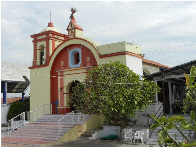
Figura 86. El templo de San Pedro Apóstol Huilotepec en 2016. Es el único templo del sector Zapoteco del Istmo que conserva sus muros de adobe y tabique y cubierta de tejado. Imagen del autor.
