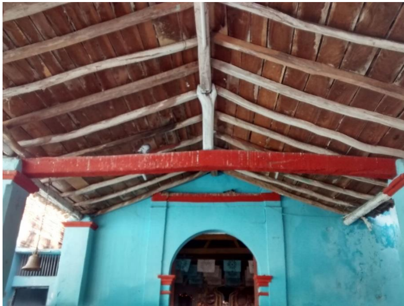
Figura 103. Sistema estructural de cubierta de tejado soportado por planchas y un horcón en el centro de la viga. Aspecto del tejado de la capilla del Señor de la Misericordia Juchitán en 2017. Foto del autor.
