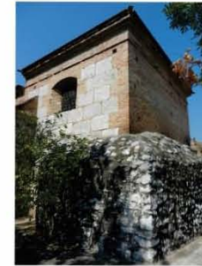
5. Las remodelaciones del templo están presentes en los distintos materiales que se aprecian en la estructura. Son: piedra de cerro, bloques de mármol, tabique y piedra bola de río.
