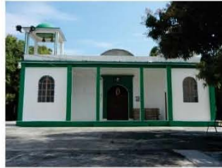
FACHADA PRINCIPAL TEMPLO
