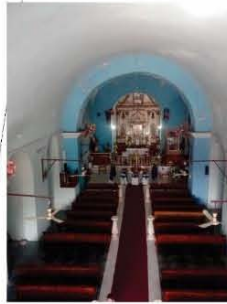
4. El templo tiene capillas criptocolaterales por lo cual la bóveda de cañón de la nave no está soportada por arcos fajones. Es una nave rasa que distingue al ábside.
