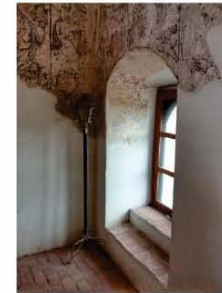
6. Las celdas de los religiosos tienen una ventana amplia con bancas de tabique adosadas. Hoy se ocupan como salas para impartir talleres.
