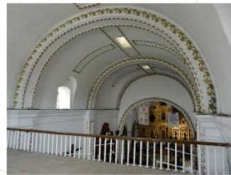
6. La bóveda de cañón vista desde el coro. Es notable el arco toral en forma de media luna. Los domos se abrieron fines del siglo XX.
