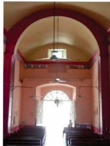
4. Esta vista del interior hacia la entrada principal, revela la estructura que soportó la tarima de madera del entresijo del coro. Similar al templo de Huilotepec.
