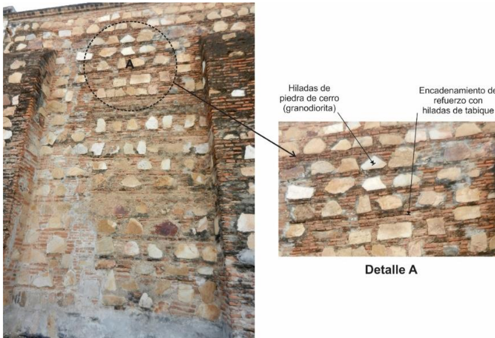
Figura 98. Sistema constructivo del templo de Asunción Ixtaltepec, Oaxaca. Esta obra es posterior a 1550 y ya se utilizan los encadenamientos de refuerzo de tabique en la estructura soportante como una respuesta a la sismicidad de la región. Imagen del autor.
