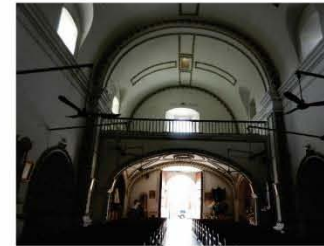
4. Aspecto del interior desde el presbiterio hacia el coro. Se aprecian nichos en los muros laterales y el entropiso del coro, así como la bóveda de cañón.
