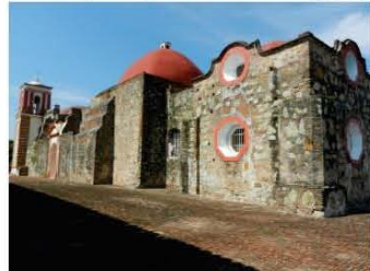
6. Fachada sur del templo. en primer plano el camarín construido a finales del siglo XVIII.
