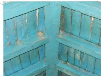
Detalle de la cubierta de tejado. Se aprecia la viga de la cumbre, los morillos transversales y el entablado de bilhuanas . Sobre este lleva una capa de lodo y cal donde se colocan las tejas.
