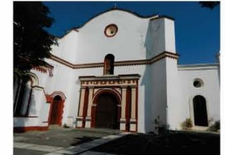
7. La portada del templo de Santo Domingo conserva sus rasgos originales. Su entrada enmarcada por un arco triunfal es característica de las construcciones dominicas del siglo XVI.
