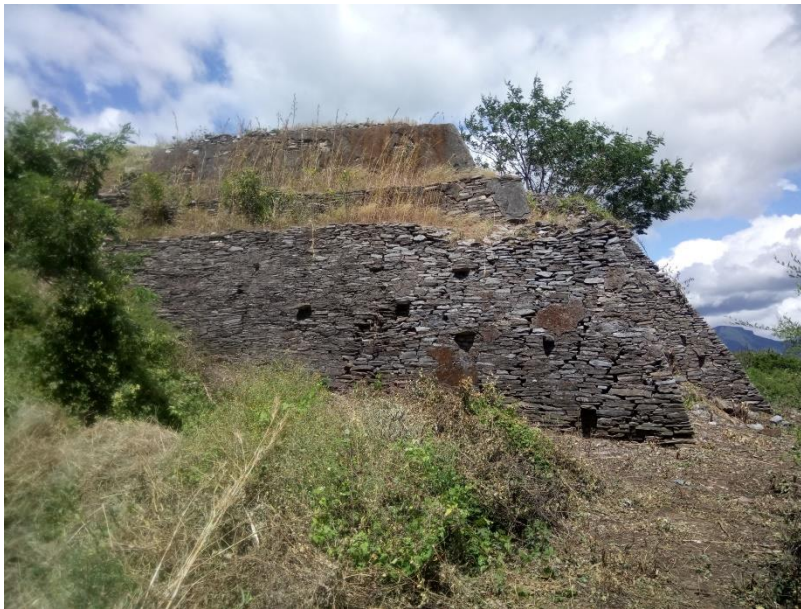
Figura 94. Estructura o pirámide oeste en el sitio arqueológico Guiengola , Tehuantepec, Oaxaca, en 2017. Para construir los muros se utilizó piedra laja caliza unida con mortero de tierra y los paramentos tuvieron aplanados de mortero de cal y arena. Foto del autor.
