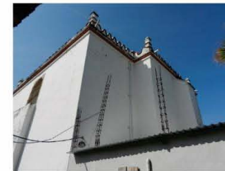
7. Detalle del contrafuerte a la mitad del muro testero. Característico de los templos construidos entre 1550 y 1555 en el Istmo.
