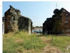
6. Vista desde el presbiterio hacia la nave del templo. Hoy, las ruinas de esta iglesia están en riesgo de desaparecer ya que la comunidad quiere construir una plaza en su lugar.
