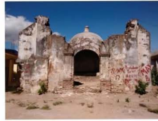
2. Aspecto de la fachada del templo. La portada estuvo contenida por dos contrafuertes. En segundo plano se aprecia la capilla mayor.
