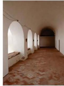
5. Corredores del segundo nivel que comunican con las celdas de los religiosos. Su cubierta es bóveda de cañón y vanos de medio punto.
