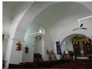
6. Interior del templo. Se ven los arcos fajones y pilares adosados que soportan las bóvedas vaídas de la nave y presbiterio.
