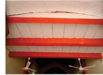
3. En templos con muros de adobe y tabique, el entrepiso del coro es una tarima de vigas y tablas. El ancho del inmueble se condiciona a la longitud que una viga puede cubrir.
