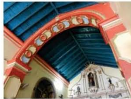
6. Aspecto de la cubierta del templo. El tejado se soporta en arcos fajones. Los tramos entre ejes longitudinales son cortos, condicionado por la longitud de las vigas de la cumbre.
