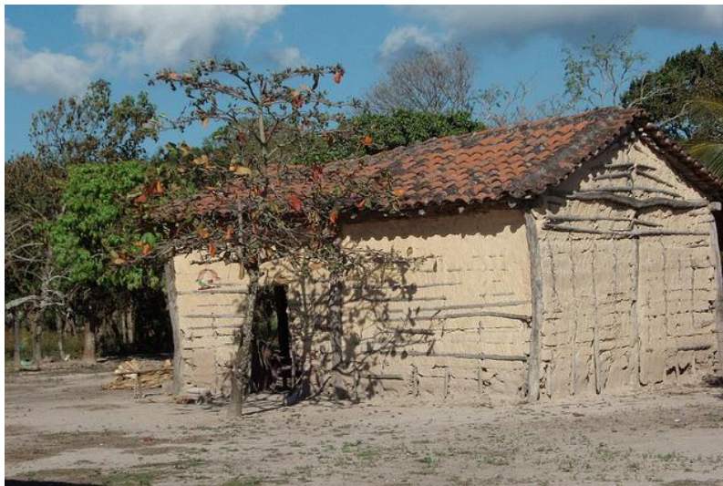
Figura 88. La casa de lodo y cubierta de teja, beñe yoo . Este tipo de construcciones aún se encuentran en localidades del Istmo Sur. La fotografía es de 2006 y muestra una vivienda en la población de La Mata, agencia municipal de Ixtaltepec, Oaxaca. Foto del autor.
