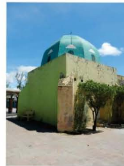
4. La capilla mayor de la Santa Cruz. Esta estructura fue la primera que se edificó en Tlacotepec. Se aprecia el volumen cuadrangular y los contrafuertes en diagonal en las esquinas del muro testero.
