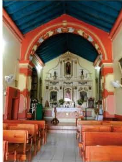
4. Interior del templo de San Pedro. La cubierta de tejado se soporta en arcos fajones, pilares adosados y en los muros laterales.
