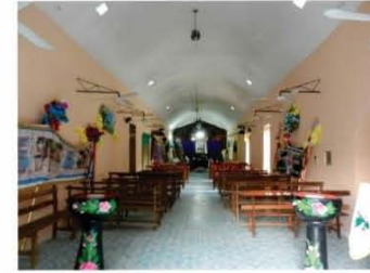
3. Interior del templo de Santiago. Se nota la nave rasa y la extensa bóveda de cañón que cubre la nave y el presbiterio. Los vanos del primer plano son de la primitiva iglesia.
