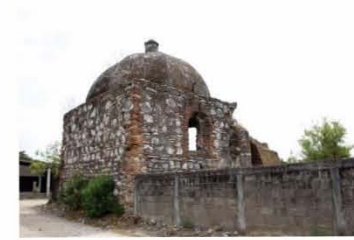
3. El presbiterio del templo fue una capilla mayor. Esta vista posterior muestra su volumen cuadrangular. La cubierta original fue de tejado y se sustituyó por la bóveda gallonada.
