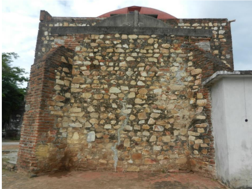
Figura 96. Detalle del sistema constructivo del muro testero y contrafuertes de la capilla mayor, ábside, del templo de San Jerónimo Doctor Ixtepec, Oaxaca. La mampostería es de piedra amarilla de cerro (granodiorita), piedra bola de río y dentellones de tabique para perfilar esquinas, unidos con mortero de cal y arena. Foto del autor.
