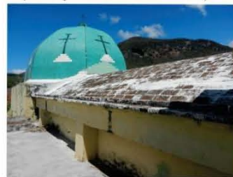
3. La bóveda gallonada cubre al presbiterio del templo; el tejado original se sustituyó por una bóveda de cañón para cubrir la nave y sus ampliaciones.
