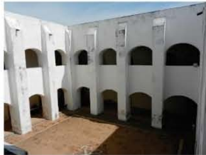
1. El claustro es de dos niveles. En el primero están las dependencias comunes y en la planta alta los aposentos privados. Tuvo una fuente en el patio arbolado. Hasta el año de 1995 estuvo sin aplanar. Todo está construido con tabique.
