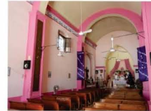
3. La cubierta de teja se colocó sobre arcos fajones. Al sustituirse por una bóveda de cañón, estos elementos se reutilizaron. Aquí se ve un tramo de la nave y al fondo el presbiterio.
