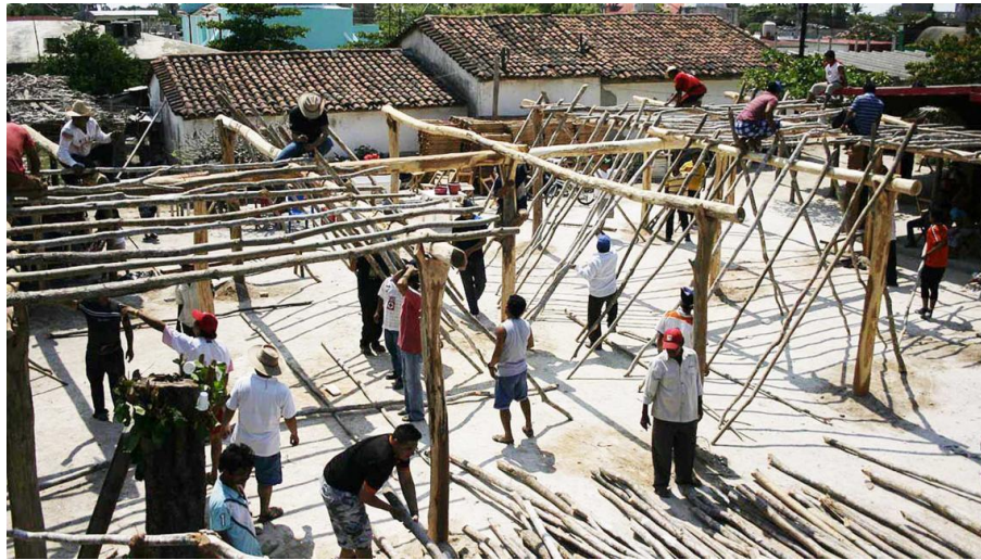
Figura 91. Hombres armando una enramada en Tlacotepec, Oaxaca. Se aprecian los horcones que soportan las soleras. Sobre estas se apoyan los morillos donde se coloca la palma. Imagen de Martín Vargas en www.nvinoticias.com
