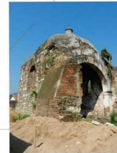
5. Otro aspecto de la capilla mayor de La Magdalena . Se ven los contrafuertes y muros que se añadieron para formar la nave del templo. La capilla se utilizó como presbiterio.
