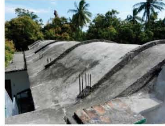
2. La cubierta de tejado original se sustituyó por una bóveda de cañón que cubre todo el cuerpo de la iglesia, desde la nave hasta el altar mayor. Es de concreto armado.
