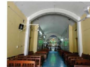
6. En esta imagen se notan las ampliaciones de la nave y la bóveda de cañón que la cubre. Estos crecimientos son comunes en los templos y capillas de barrios en el Istmo.
