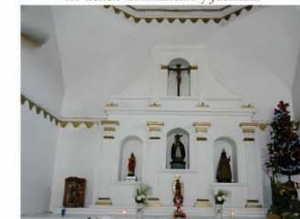
6. EL retablo original se perdió. Lo sustituyó uno de tabique con nichos, pilares y peanas molduradas. Conserva las imágenes virreinales, aunque deterioradas.
