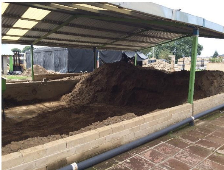
Figura 51. Material de excavación
