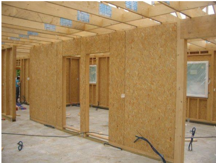
Figura 17. Tablero de madera reciclada usado como muro divisorio
