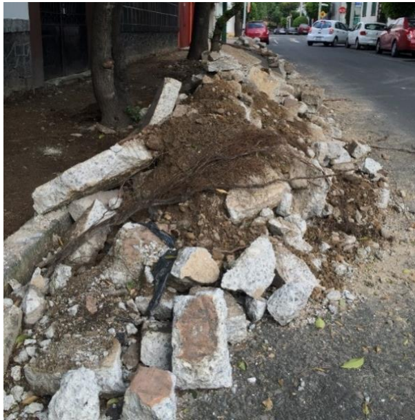
Figura 3. Residuos de construcción sin tratamiento de separación
