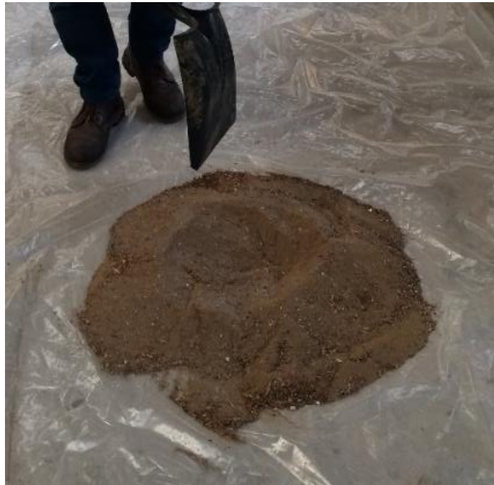
Figura 75. Mezcla de materiales en seco
