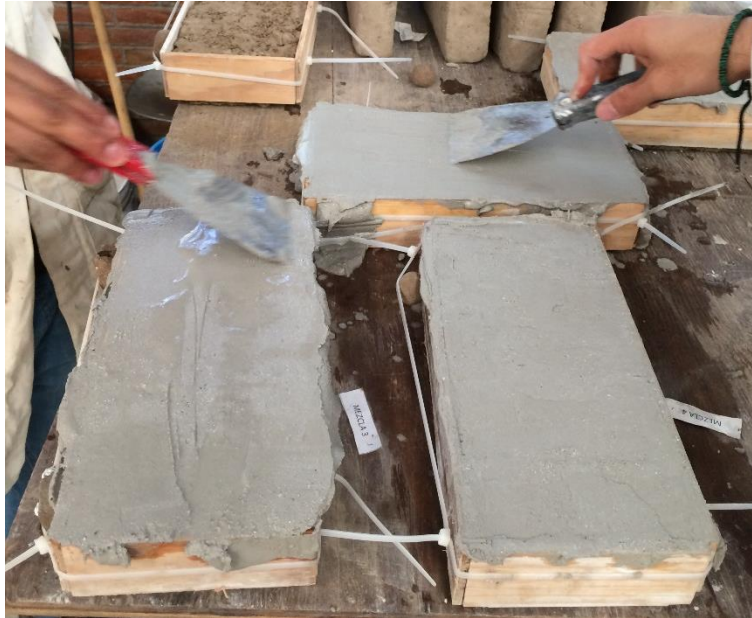
Figura 94. Acomodo de mezcla yeso-cemento y texturizarían de la superficie
