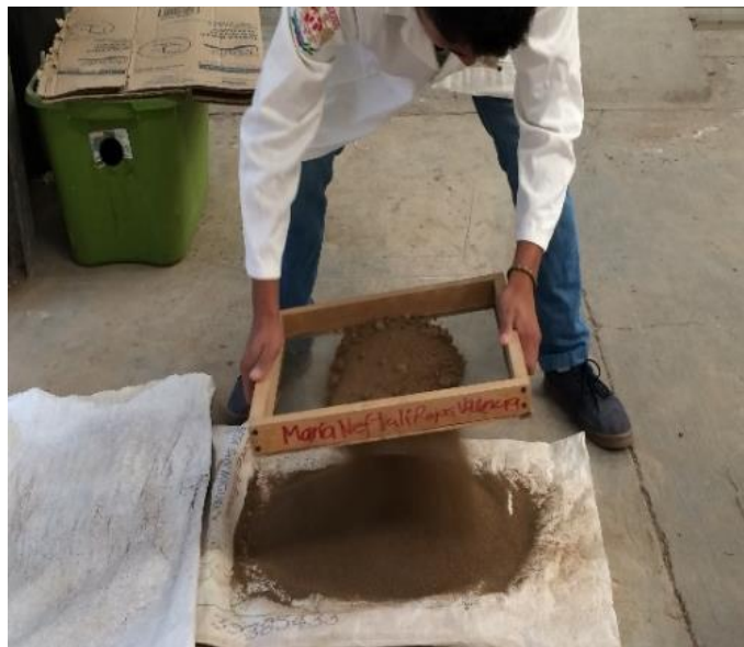
Figura 53. Cernido de material de excavación
