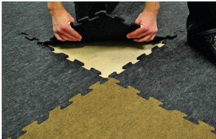
Figura 23. Colocación de suelos ecológicos ECORE
