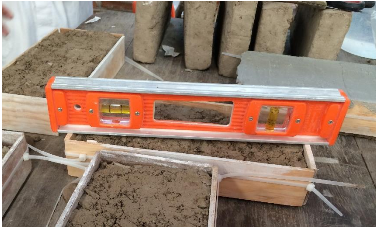
Figura 91. Nivelación de encofrado
