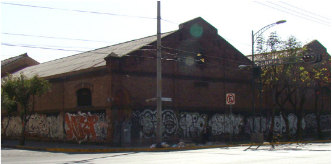
Fachada Norte, hacia Av. Eulalia Guzmán esquina con Sabino. Vista actual del predio.
