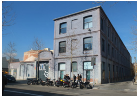
Vapor Lull, imagen del Observatorio de Barcelona para la Rehabilitación Arquitectónica.
