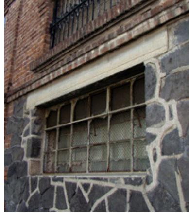
Modificaciones en fachada. Abertura de ventanas y remaches de pintura. Foto de autoría propia.
