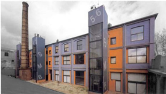
Fachada principal del edificio Vapor Lull Lofts. Imagen tomada del sitio web de CIRICI & BASSÓ arquitectura.
