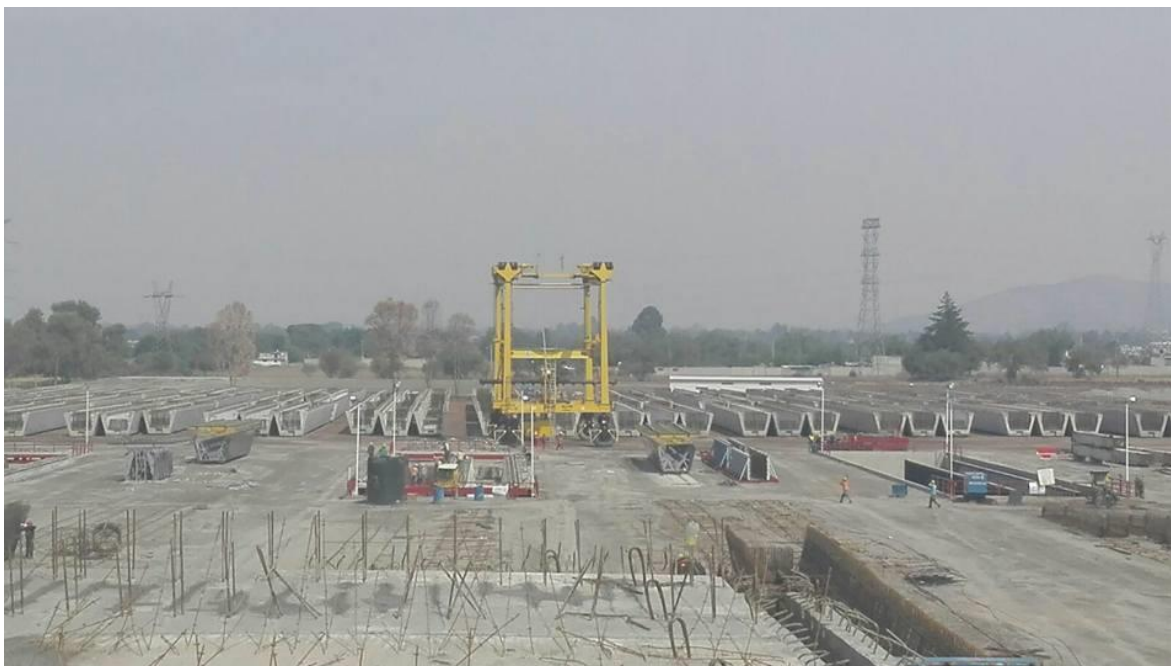
Figura 50. Trabajos de almacenamiento de traves cajón.
