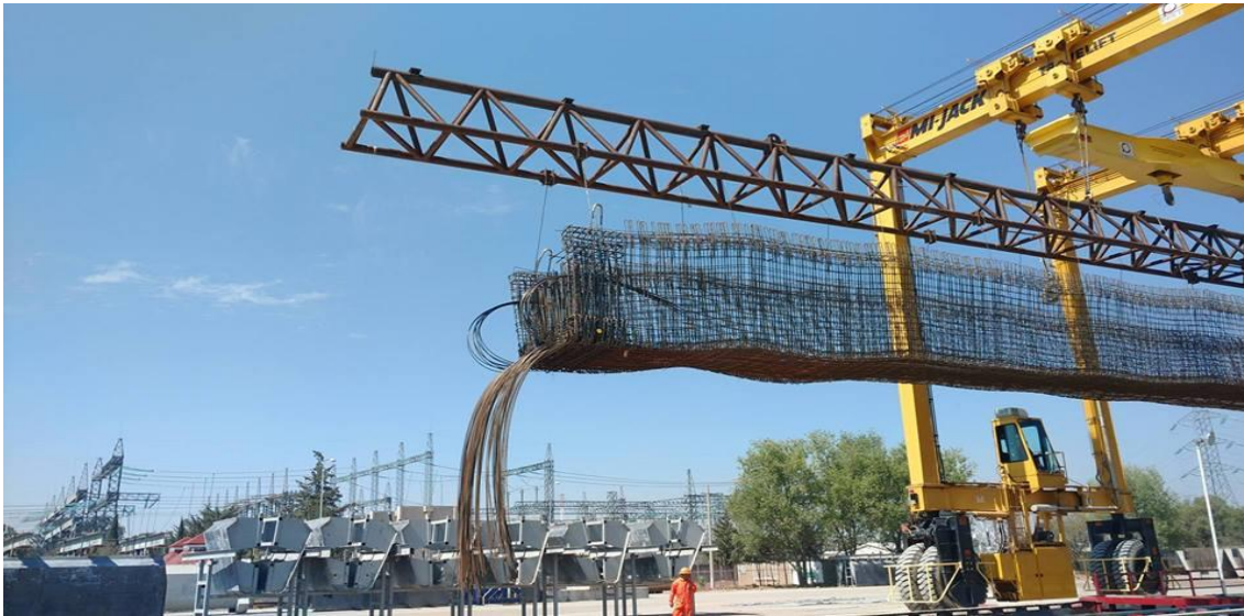
Figura 39. Carga de acero de refuerzo de trabe cajón hasta moldes de colado.
