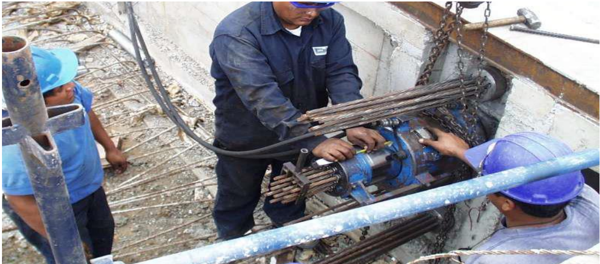
Figura 43. Tensado de torones.
