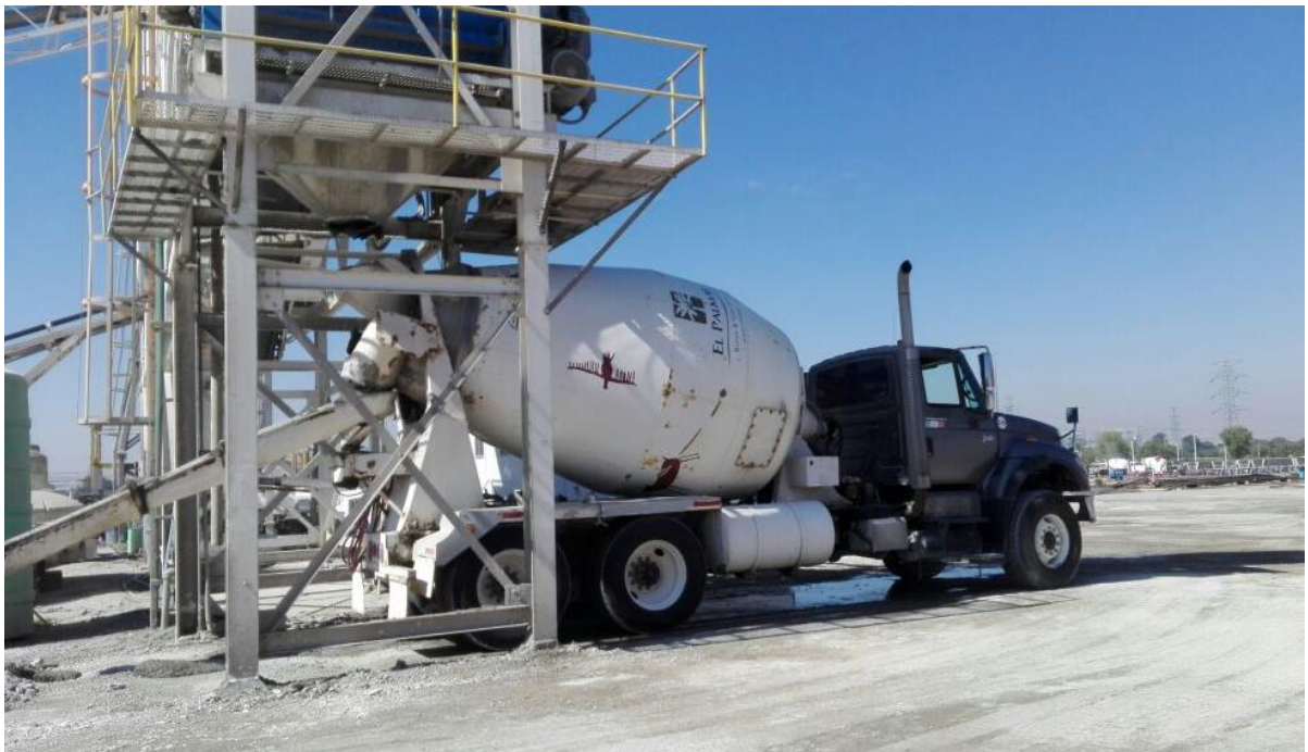
Figura 44. Dosificadora de concreto en PRET La arboleda.
