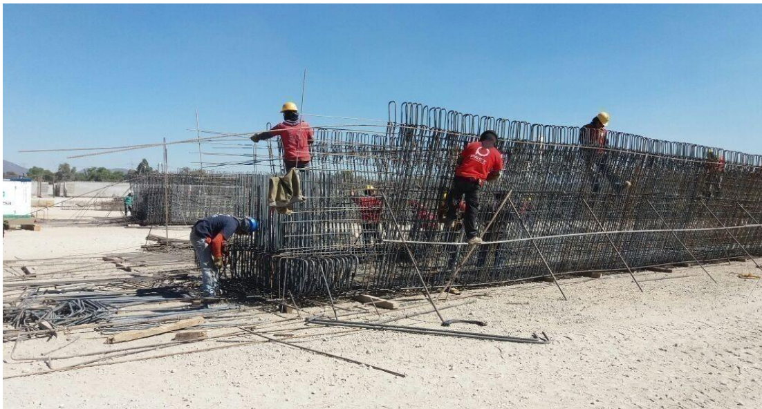
Figura 37. Habilitado y armado de acero de refuerzo para trabe cajón.
