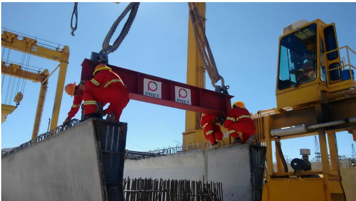
Figura 49. Extracción de trabe cajón del molde con Marco Mi Jack.
