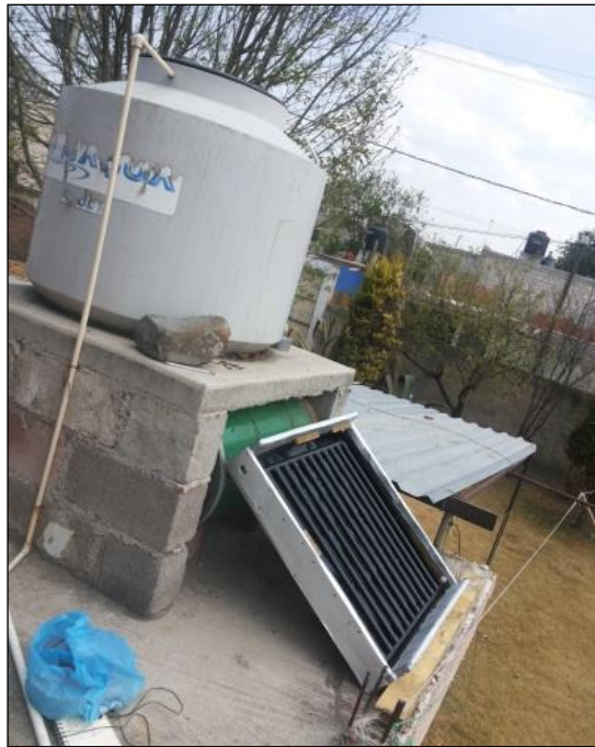
Figura 30. Posición y angulo de inclinación del calentador solar. Fuente elaboración propia.
