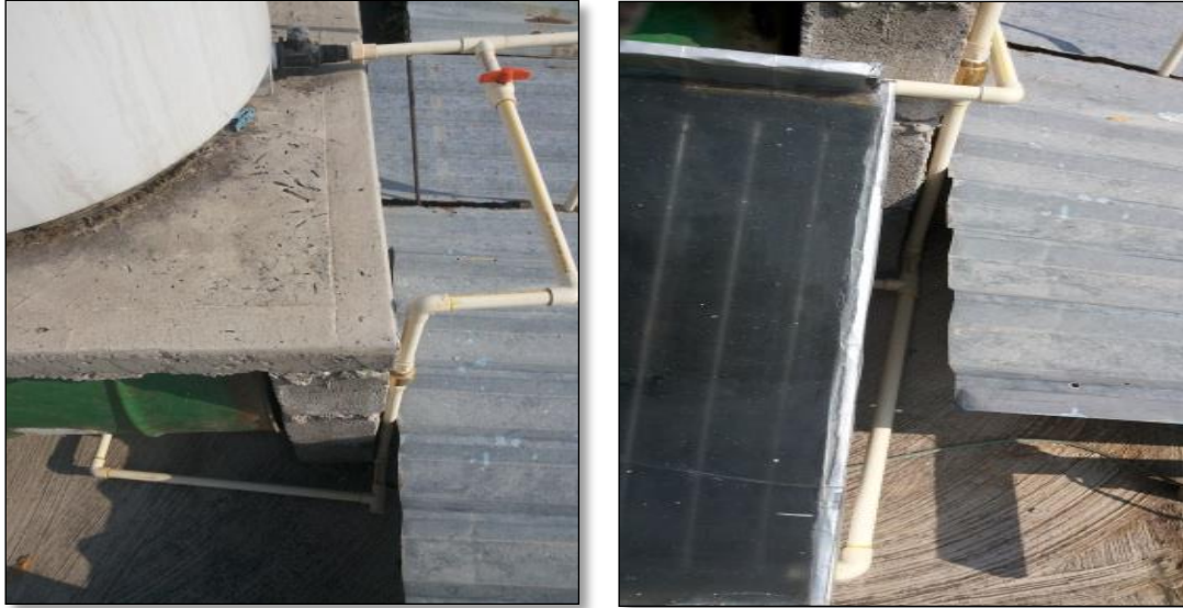
Figura 28. Instalación de tubería para agua fría: de llenado y retroalimentación. Fuente elaboración propia
