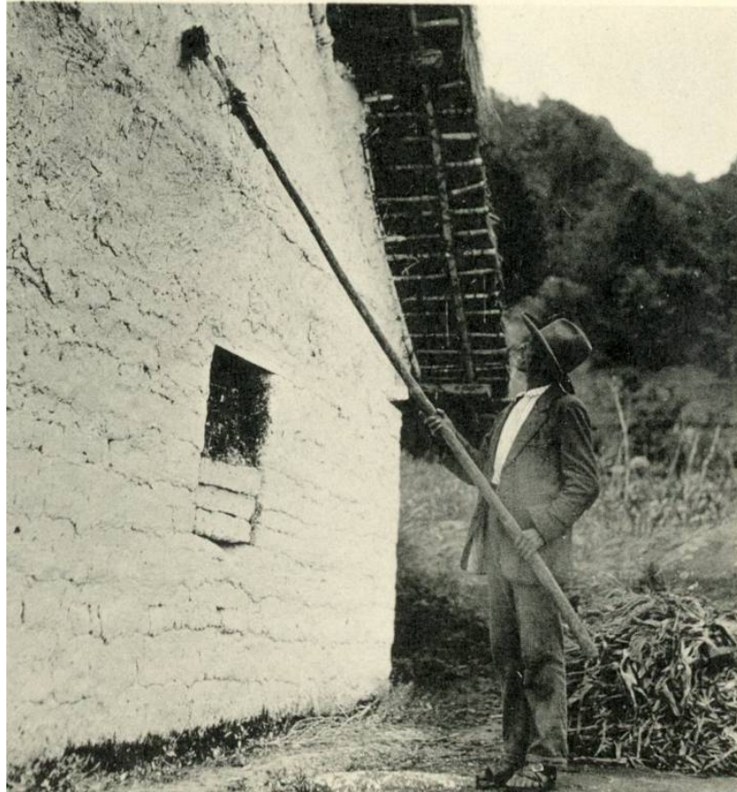
Figura 2.21. Aplicando un baño de pintura blanca a la casa. Tomado de Wauchope 1938: lámina 21d.
