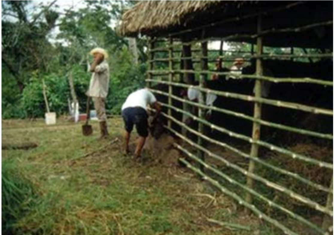
Figura 4.23. Aplicación del barro sobre el armazón. Cortesía de la Dra. Ann Cyphers.
