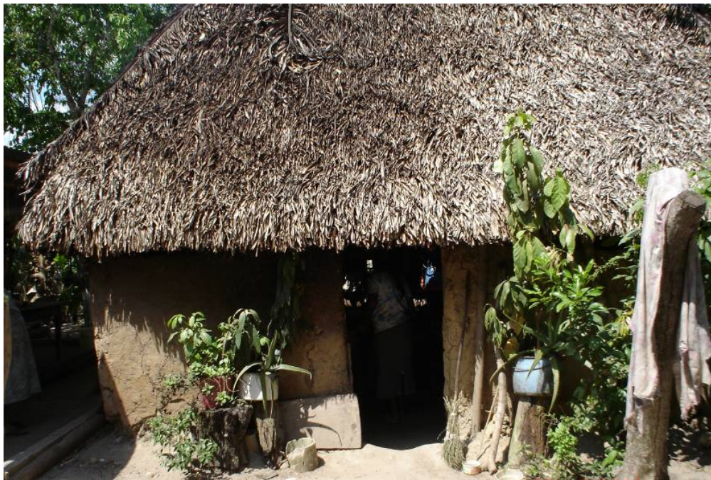
Figura 4.22. Observar el corte recto de la palma en la parte baja del techo.
