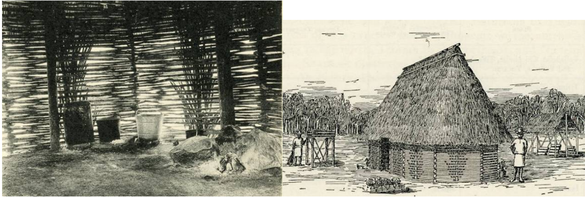
Figura 2.18. Casas con paredes de zarzo horizontal. Tomadas de Wauchope 1938: figura 24d y lámina 16b.
