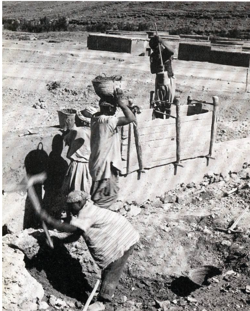
Figura 2.4. Elaborando un muro de tierra apisonada. Tomada de Oliver 1987: 82.
