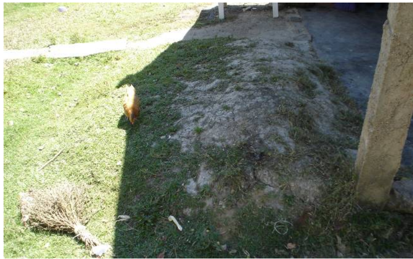
Figura 4.38. Paredes de embarro derrumbadas e incorporadas al suelo circundante a la casa.
