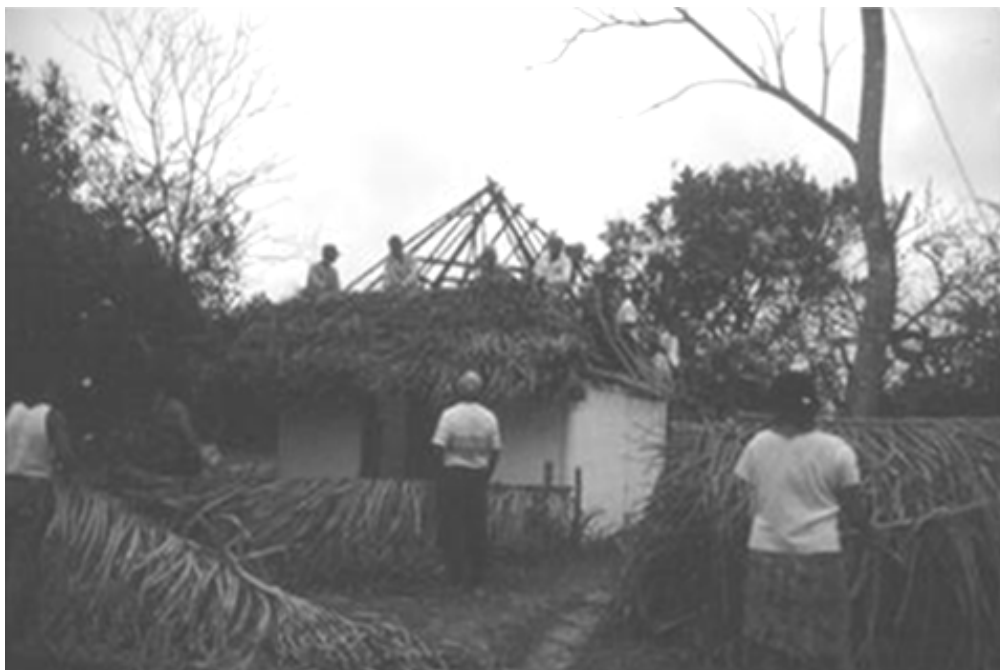
Figura 4.21. Aplicando la palma a un techo, en el poblado de Tenochtitlan. Cortesía de la Dra. Ann Cyphers.
