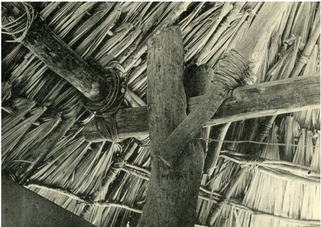
Figura 2.14. Vista de los atados en la estructura del techo. Tomada de Wauchope 1938: lámina 9b.
