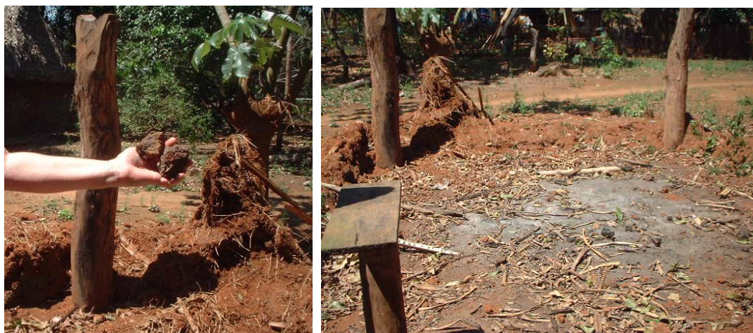
Figura 4.41. Restos de barro quemado y restos del techo quemado en una casa derrumbada.
