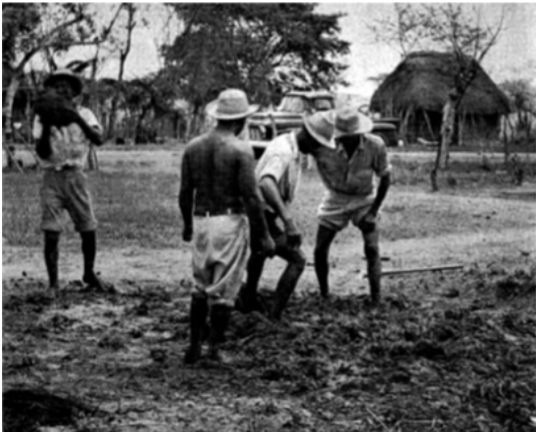
Figura 4.24. Mezclando con los pies la tierra para el barro. Tomada de Fuson 1964: figura 6.
