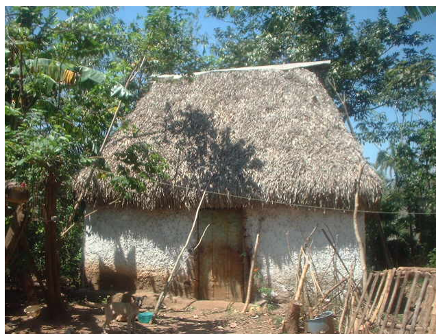
Figura 4.27. Baño de pintura blanca sobre el embarro, en el poblado de Úrsulo Galván.
