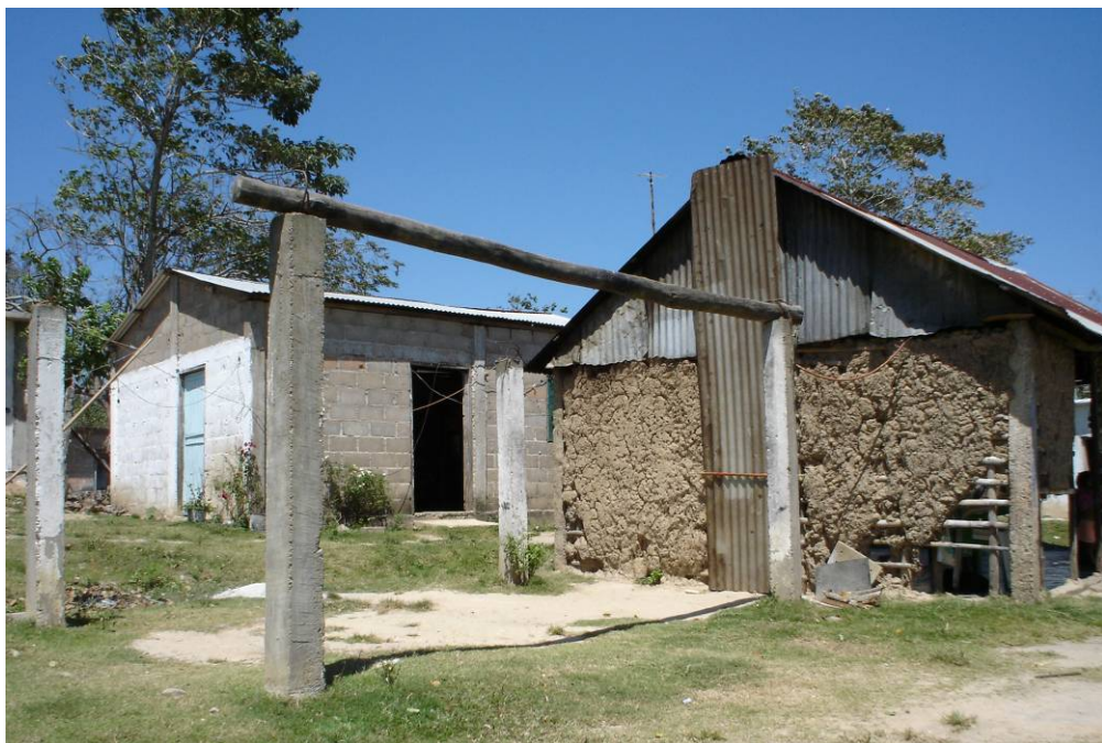
Figura 4.44. Casa de barro con 40 años de uso y con algunos cambios estructurales.
