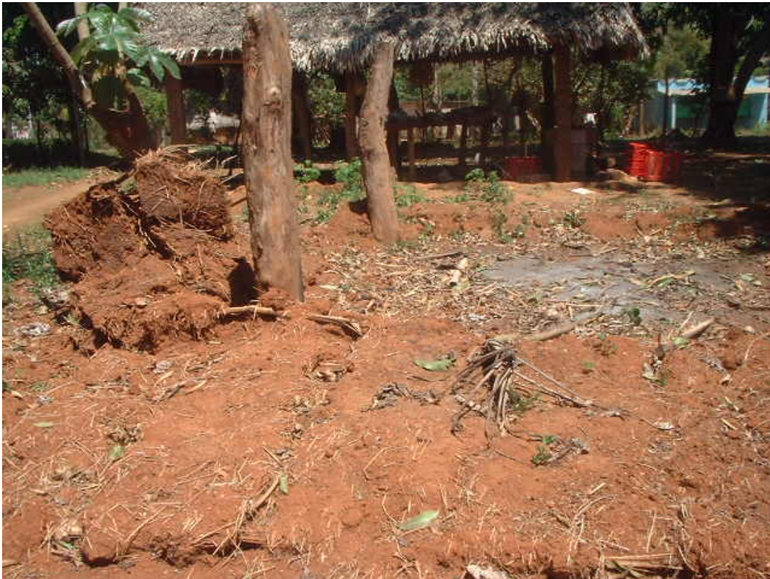
Figura 4.33. Panorama de una casa de barro derrumbada por un huracán, en el sur de Veracruz.
