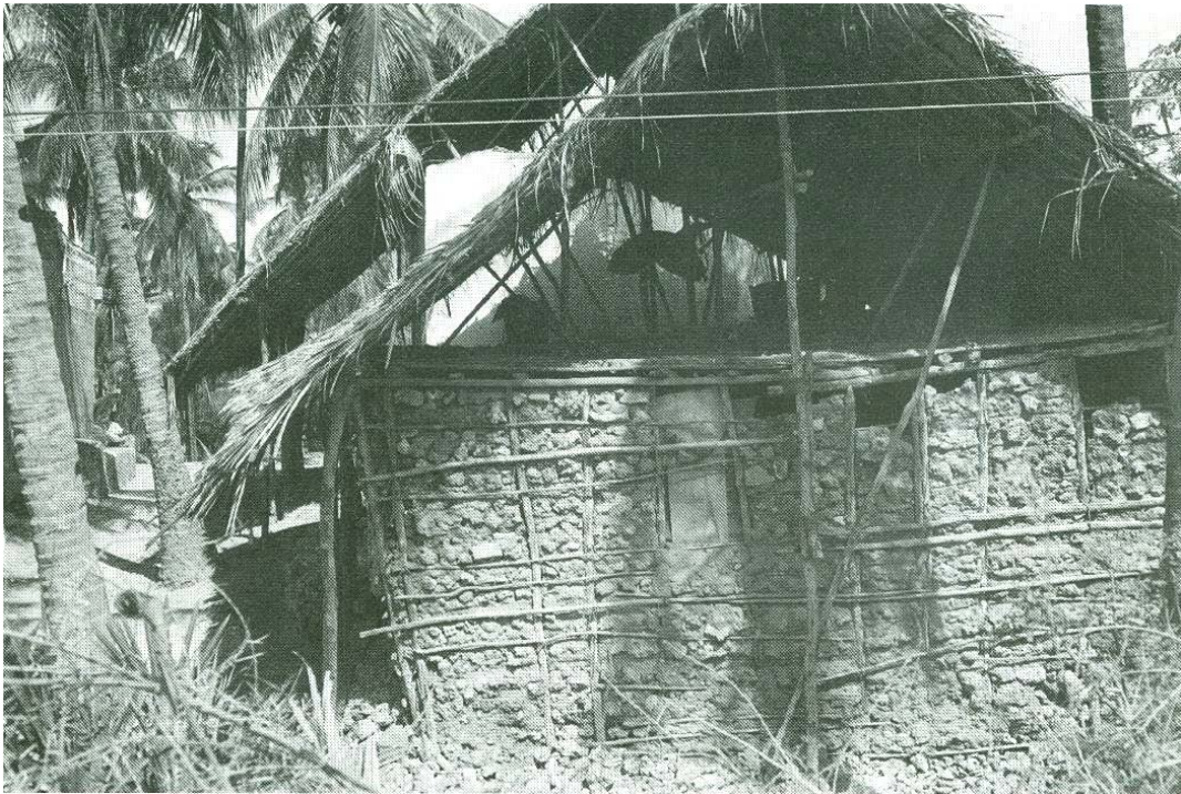
Figura 2.7. Construcción de zarzo y barro. Tomada de Oliver 1987: figura s/n página 58.
