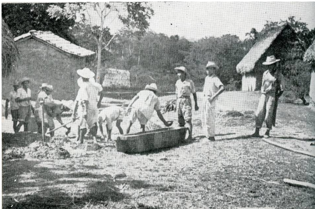
Figura 4.11. Trabajo cooperativo para la construcción con embarro en Sayula. Tomado de Guiteras 1952: figura s/n.
