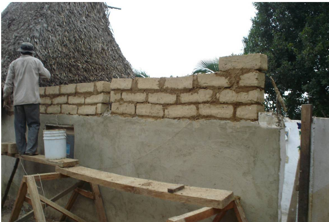
Figura 2.1. Construyendo con adobes.
