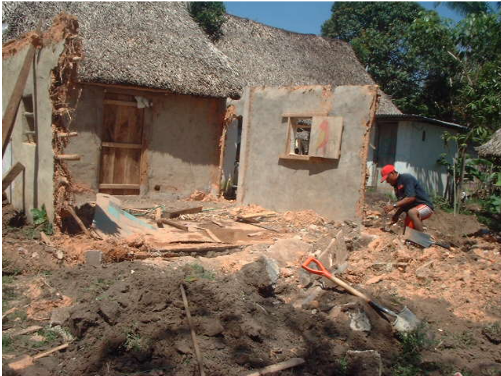
Figura 4.40. Renovación de una casa de barro con repello, en el poblado de Úrsulo Galván.
