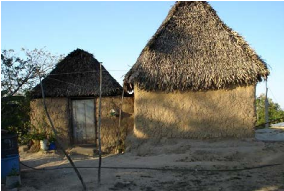
Figura 4.43. Vista panorámica de una estructura con deslave de muros.
