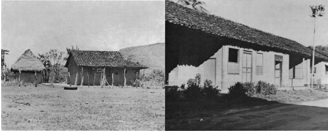
Figura 3.4. Izquierda, ejemplo de una casa quincha con influencia de materiales de tipo español. Derecha, ejemplo de una casa de españoles con materiales de una casa quincha. Tomadas de Fuson 1964: figuras 16 y 20.
