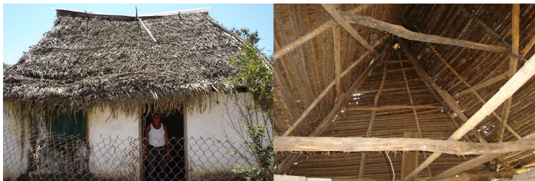
Figura 4.29. Vista interna y externa del mismo techo, en el poblado de Tenochtitlán.
