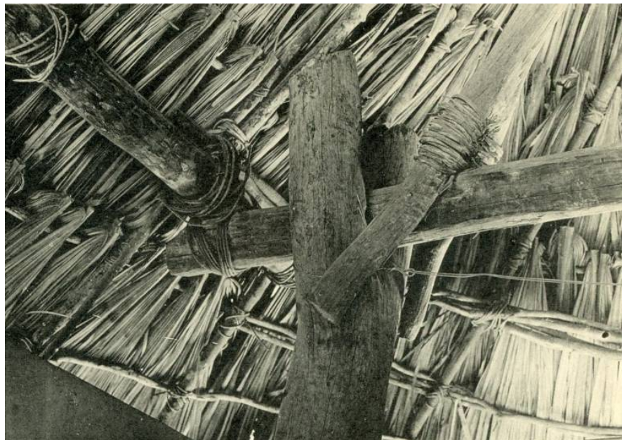
Figura 4.14. Vista de una esquina donde descansa la estructura del techo sobre la viga principal y el horcón, utilizando amarres para fijarlas, en el área maya. Tomado de Wauchope 1938: lámina 9b.
