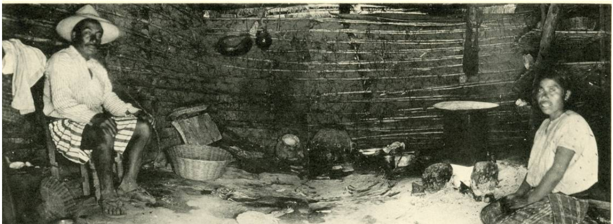
Figura 2.20. Casa con paredes de caña y adobe. Tomado de Wauchope 1938: lámina 32a.
