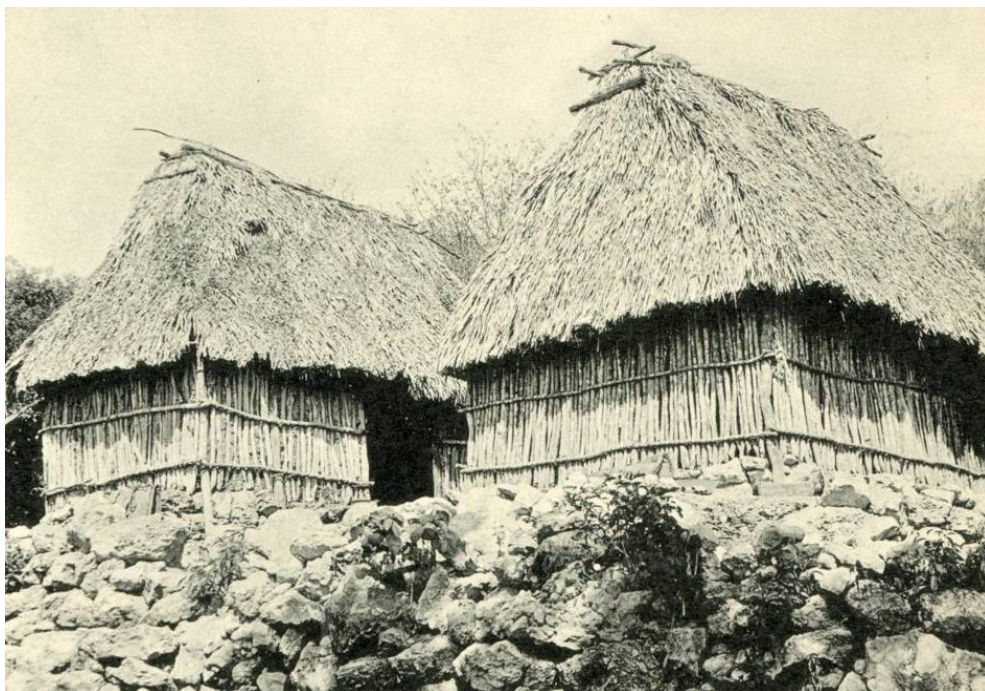
Figura 2.16. Casas con paredes de postes verticales. Tomada de Wauchope 1938: lámina 4b.
