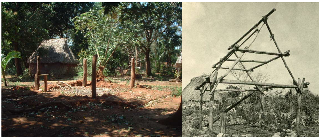
Figura 4.12. Izquierda, vista de los 4 horcones iniciales. Derecha, vista del primer conjunto de cuatro horcones, la mesa y algunas vigas de la estructura del techo, considerados la estructura inicial y principal de la casa. Esta última tomada de Wauchope 1938: lámina 22a.
