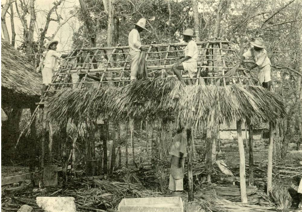
Figura 2.15. Poniendo la palma en el techo, área maya. Tomada de Wauchope 1938: lámina 27c.
