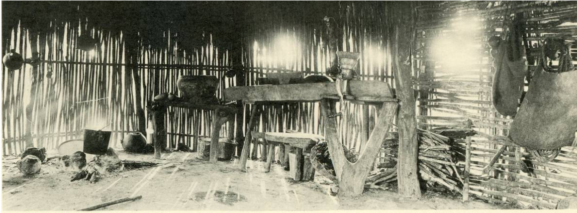
Figura 2.19. Casa de zarzo vertical, área maya. Tomada de Wauchope 1938: lámina 31a.
