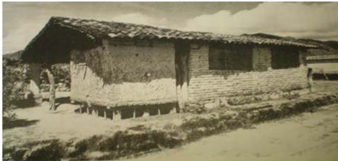
Imagen 10.3 Vivienda construida con adobe y teja de barro, región de Tierra Caliente del estado de Guerrero.
