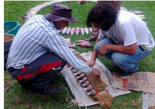
Imagen 20.0 Desplante de Muros, revisión de plomo y escuadra.
