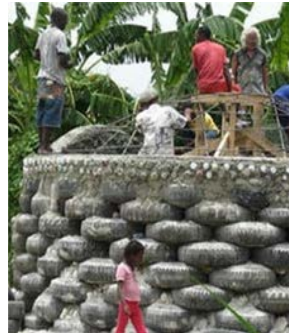
Imagen 4.0 Construcción de vivienda.
