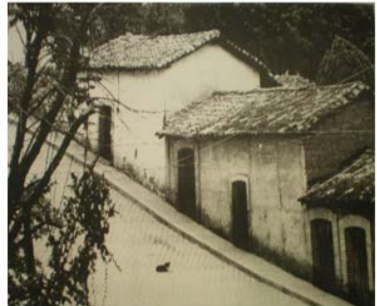
Imagen 8.4 Vivienda construida con adobe y teja de barro, zona Norte del estado de Guerrero.
