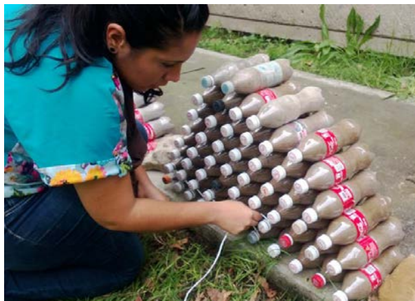
Imagen 10.0 Colocación de amarres.
