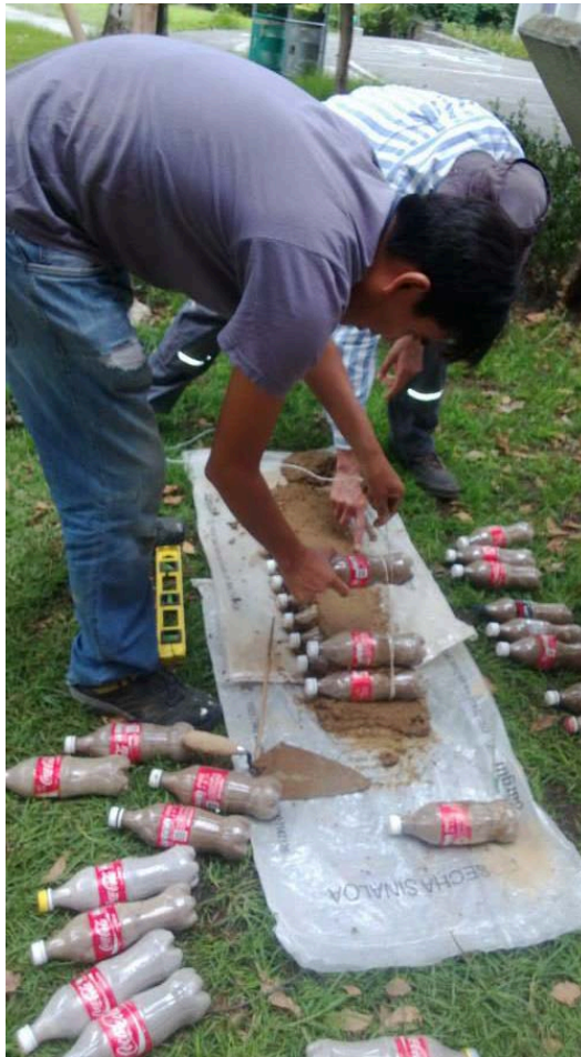
Imagen 12.0 Mortero a base de tierra arcillosa y agua.
