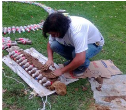
Imagen 19.0 Desplante de Muros.
