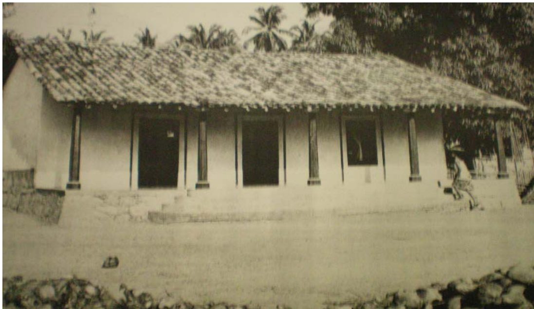
Imagen 12.3 Vivienda construida con tabique rojo recosido y teja de barro, Costa Grande del estado.
