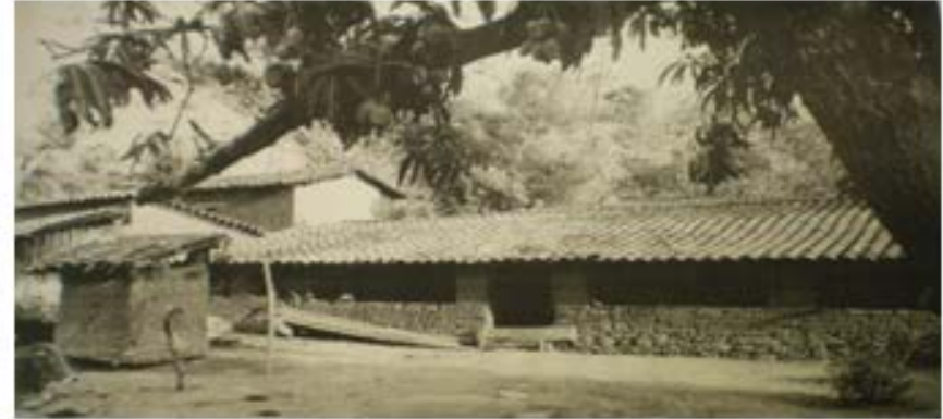
Imagen 9.2 Vivienda construida con adobe y teja de barro, en la Montaña.
