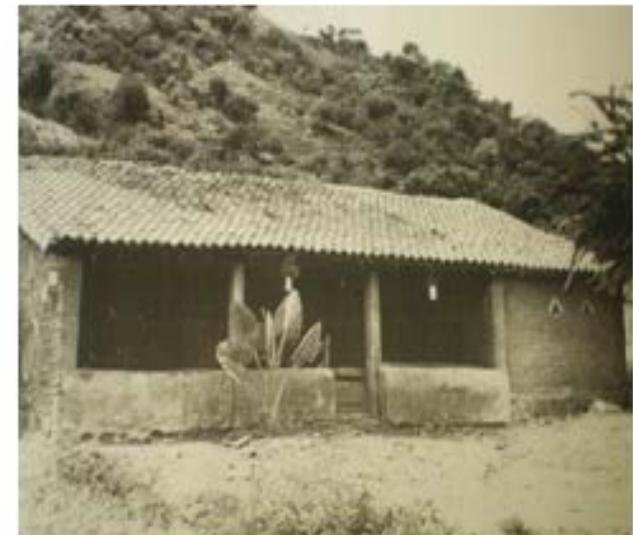
Imagen 10.4 Vivienda construida con adobe, Tierra Caliente.
