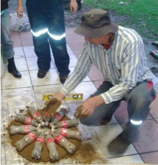
Imagen 22.0 Desplante de botellas para la construcción de columnas circulares.
