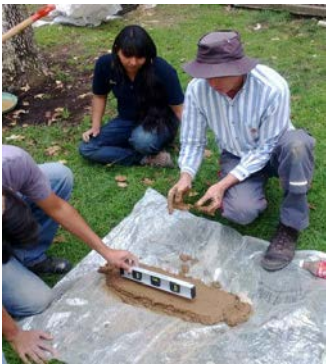
Imagen 18.0 Colocación de mezcla para el desplante de muros.
