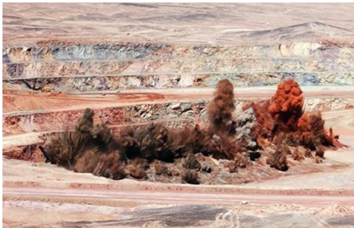
Figura 1 Voladura en Proceso. Bernaola, Castillas y Herrera, 2013, p.120.
