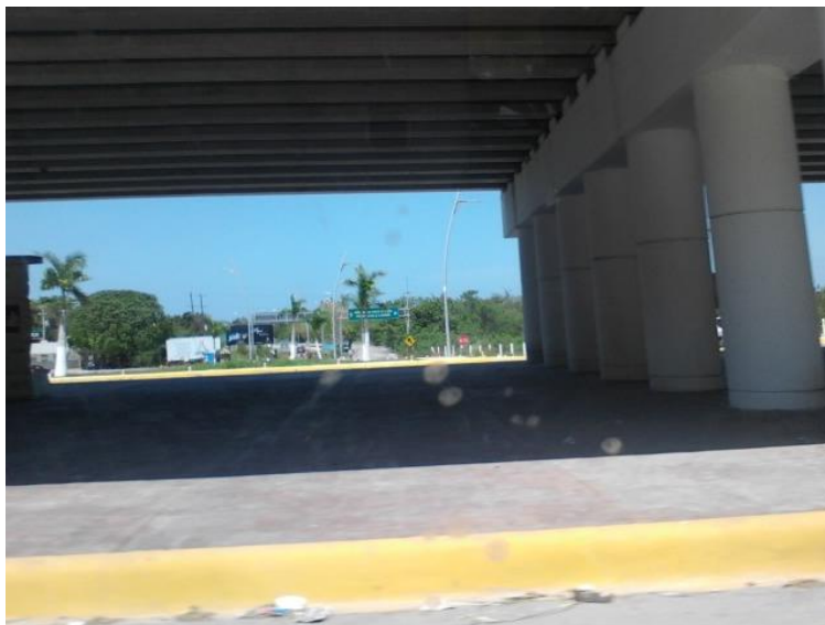
Figura 44. Camino hacia la Ciudad de Campeche. Entronque de la carretera de Campeche hacia la zona urbana de Campeche y donde se ubica parte del polígono de la Reserva de la Biosfera de Los Petenes, carretera federal 180 Campeche-Mérida. Foto tomada por Nallely Zetina Nava, abril 2016.
