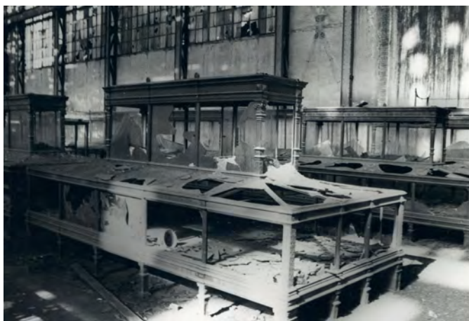
Imagen 20. Instalaciones y mobiliario del edificio en estado decadente.
