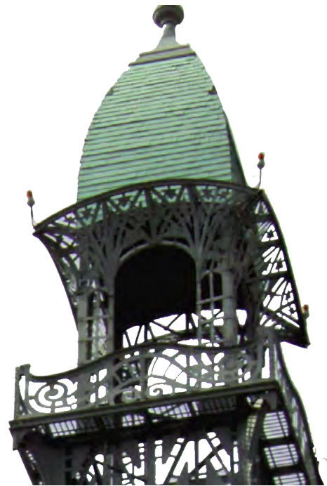
Imagen 31. Cupulines de acero, remate de las torres en fachada principal.
