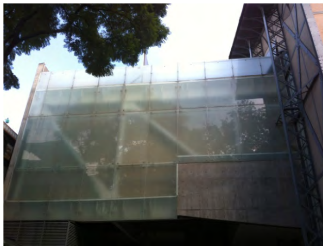
Imagen 45. El nuevo edificio perfora la fachada poniente de la estructura de hierro.
