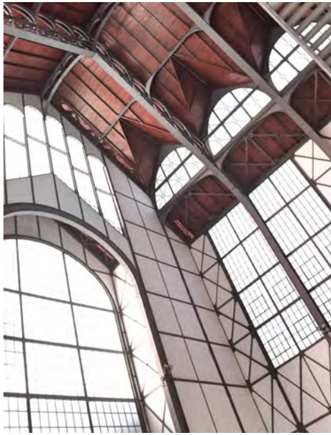
Imagen 33. Estructura interna de la techumbre.
