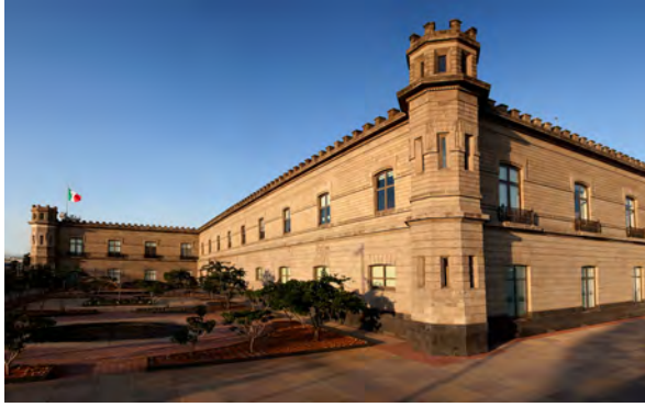
Imagen 11. Vista actual del Palacio de Lecumberri.
