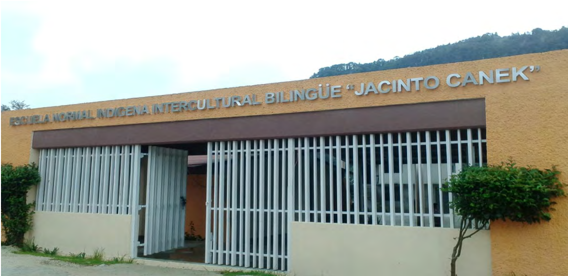
Imagen 1. Foto fachada de la ENIIB.
