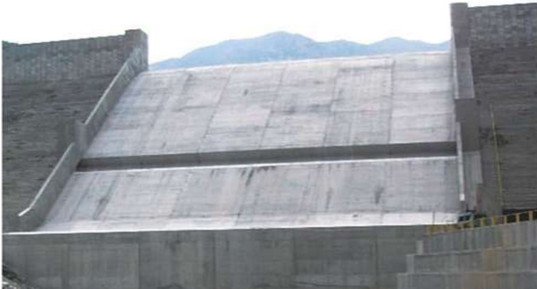
Figura 2.29. Aireador de la presa Corral de Palmas en el estado de Nuevo León.
