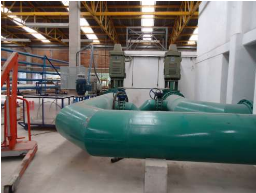
Figura 3.15 Sistema de bombas y bypass con válvulas.
