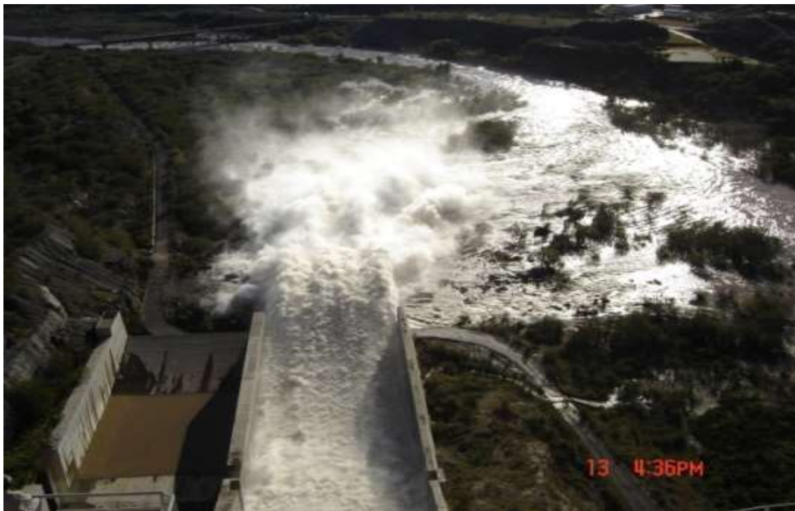
Figura 3.9 Vista del vertedor, operando las compuertas 3 y 4 descargando 870 \text{ m}^3/\text{s} .
