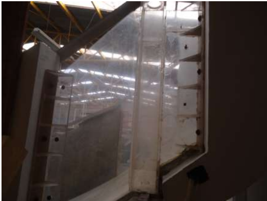
Figura 3.17 Aireador (margen izquierdo).
