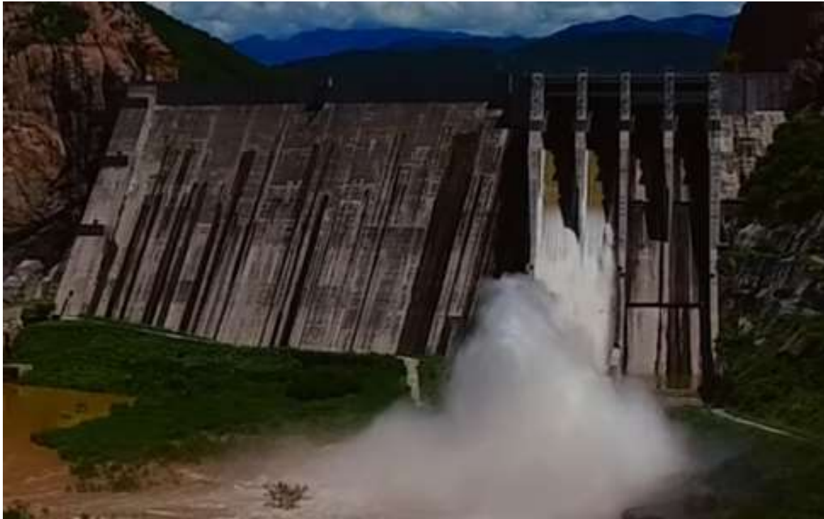
Figura 3.8. Vista frontal de la presa Huites.
