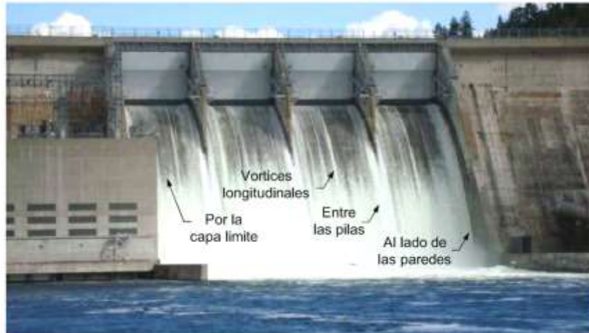
Figura 2.16. Formas de arrastre de aire en un vertedor- Canyon Ferry Montana
