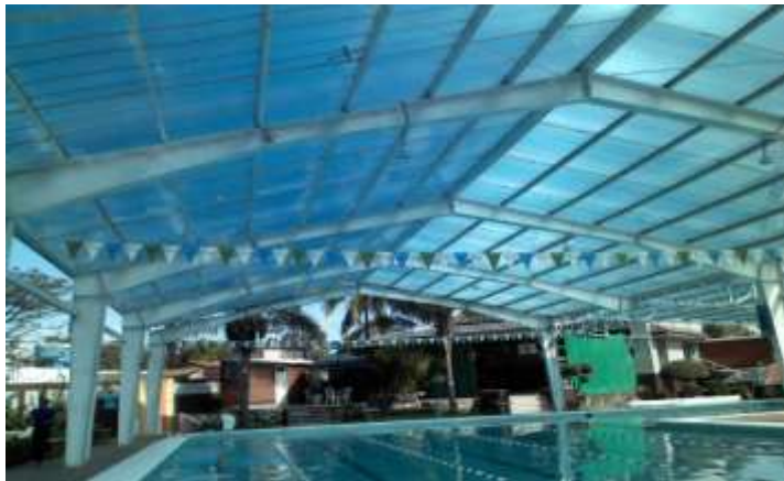
Vista de la cubierta de la alberca.
