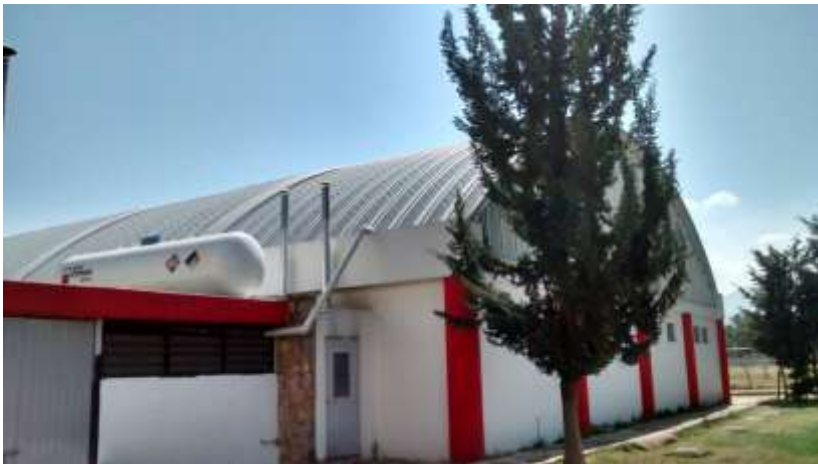
Vista de fachada poniente de la bodega de alberca, donde se localizan los servicios de regaderas y vestidores
