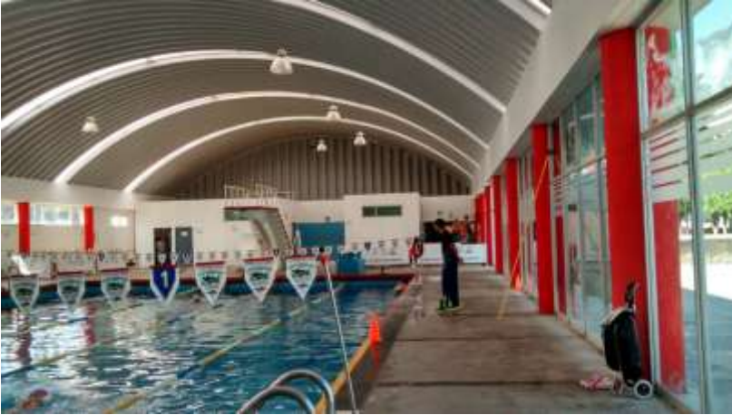
Vista de alberca donde al fondo se encuentran los servicios.
