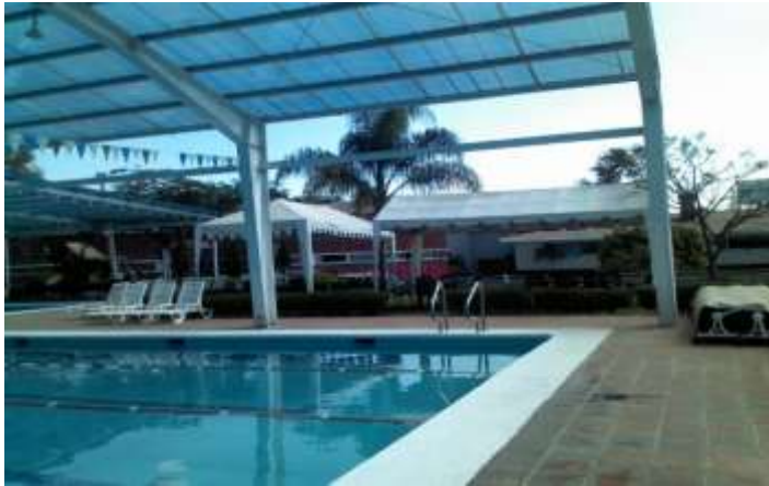
Vista de una de las dos escaleras que tiene la alberca.
