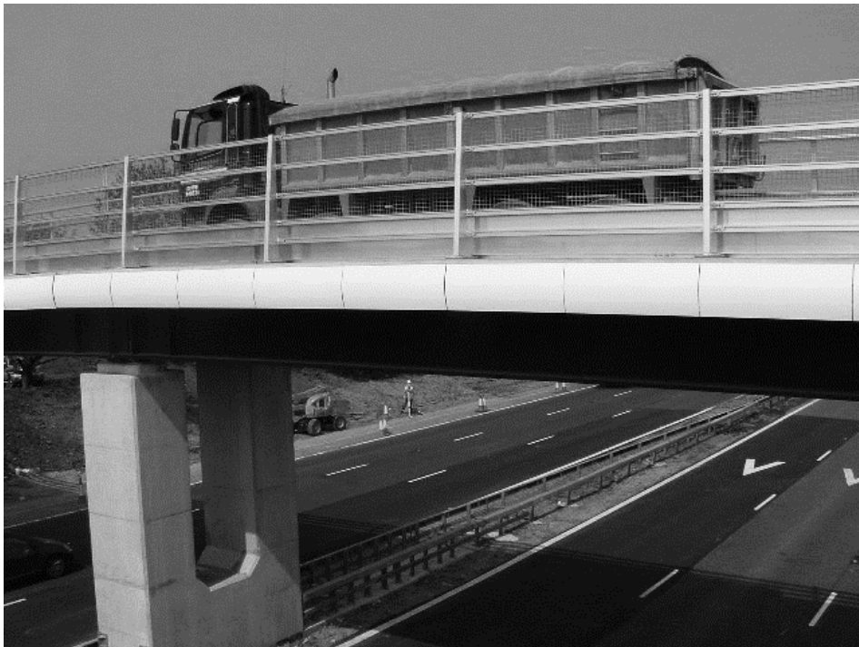
FIGURA 5 - AUTOPISTA M6 EN LANCASHIRE, REINO UNIDO. Ídem.
