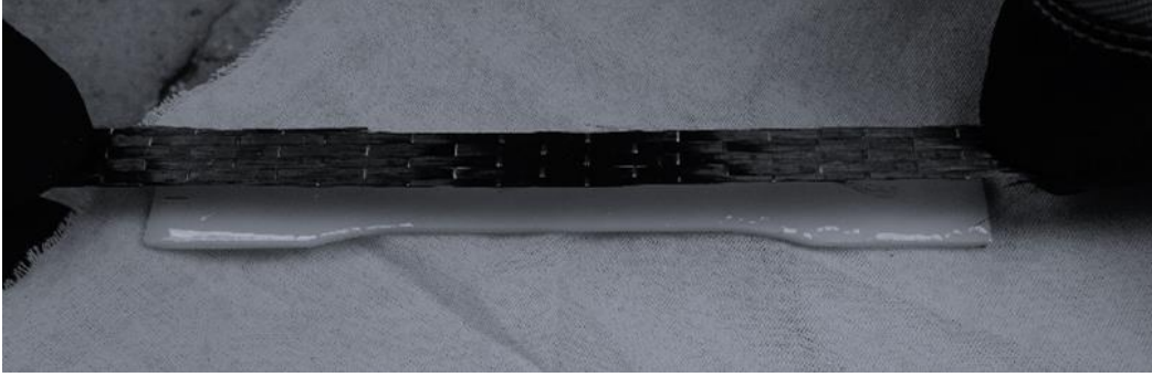
FIGURA 51 APLICACIÓN DE RESINA Y TIRA DE FC.
