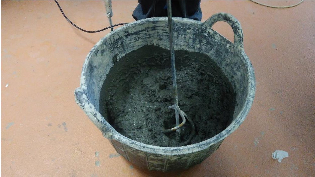
FIGURA 19 BATIDO DE MEZCLA DE MORTERO. Ídem.
