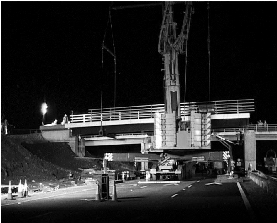
FIGURA 3 - AUTOPISTA M6 EN LANCASHIRE, REINO UNIDO. Ídem.
