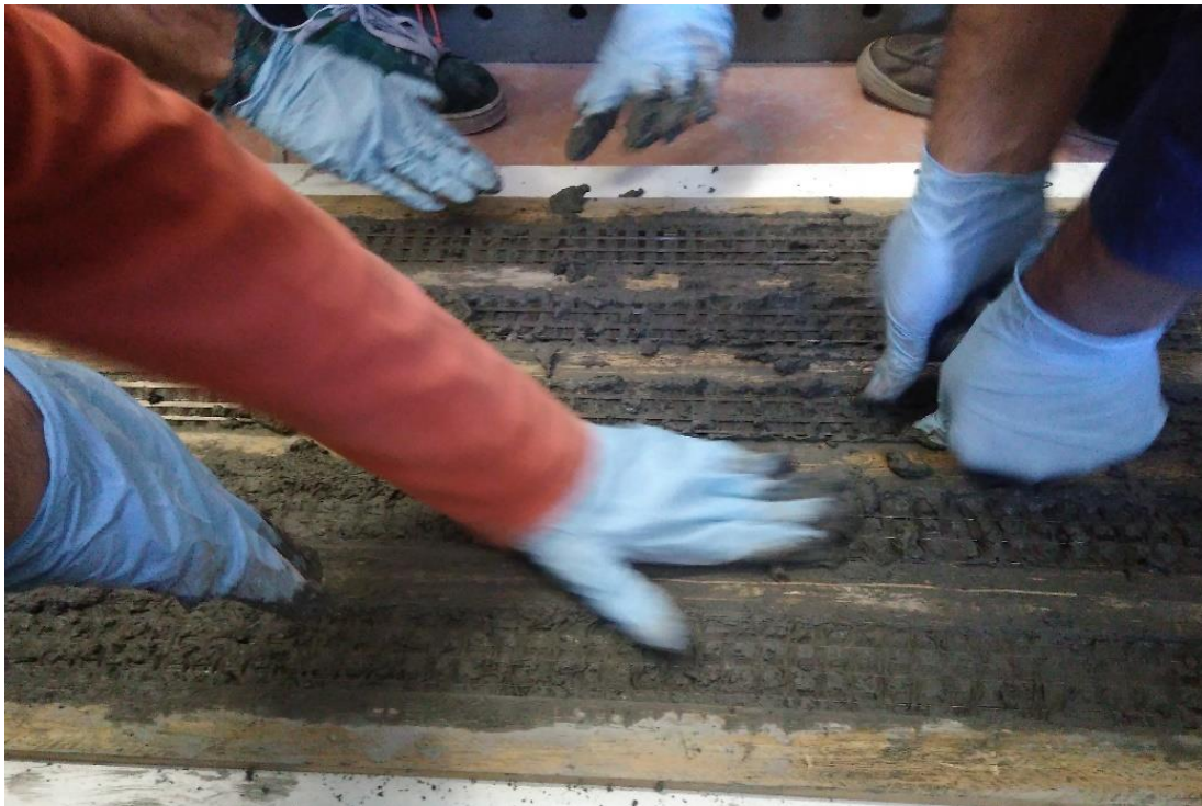
FIGURA 21 APLICACIÓN DE SEGUNDA CAPA DE MORTERO. Ídem.
