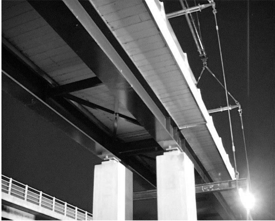
FIGURA 4 - AUTOPISTA M6 EN LANCASHIRE, REINO UNIDO. Ídem.
