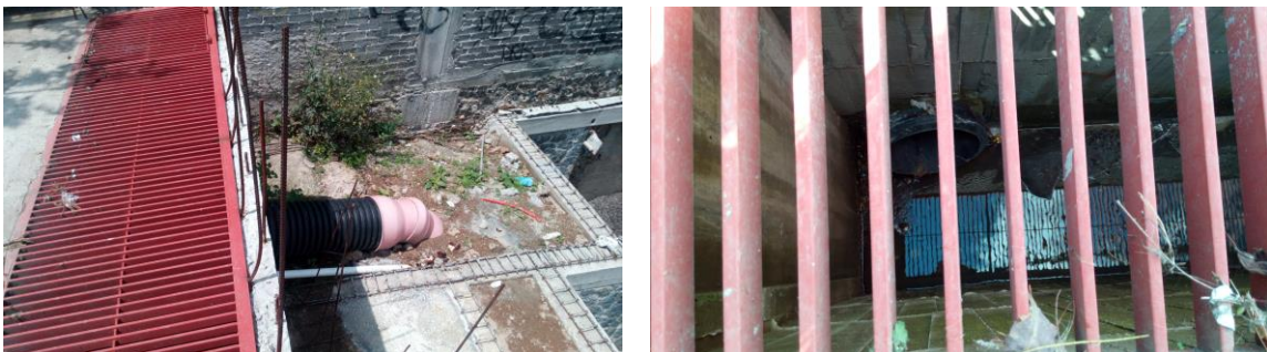
Figura 3. 15 y Figura 3. 16 Obra hidráulica reciente en la zona
