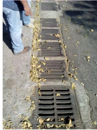
Figura 3. 12 y Figura 3. 13 Calle de Tekal, se pueden observar los desniveles y las alcantarillas usadas para drenar el agua que corre por esa vialidad, pero no son suficientes
