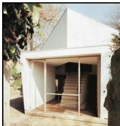
Imagen 5.13. Las escaleras del pabellón en su relación interior exterior.
