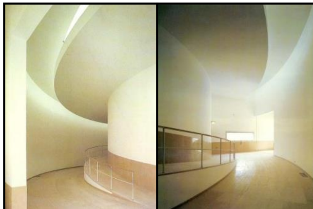
Imagen 5.6. Los pasillos donde las pendientes de las rampas permiten la circulación inclusiva.
