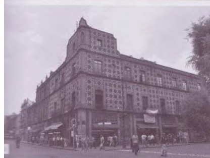
Ilustración 95. Antes y después de la remodelación del edificio en la esquina de Calles Cinco de Mayo e Isabel La Católica, Centro Histórico de México.
