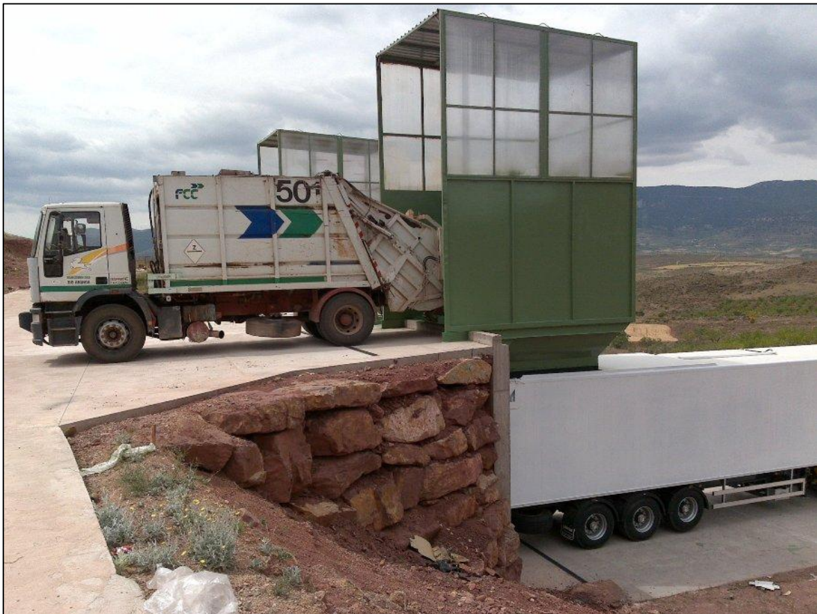
Figura 8 Estación de transferencia, COGERSA
