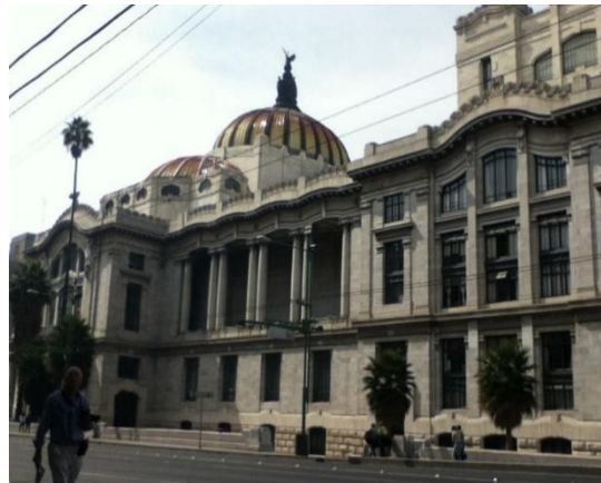
Fachada lateral derecha del Palacio de Bellas Artes. Foto Miledy Abarca
