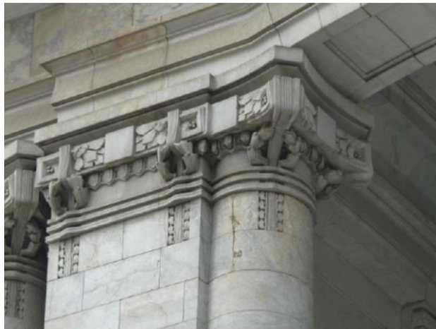
Columna monolítica diseñada por el arquitecto italiano Adamo Boari. Foto de archivo
