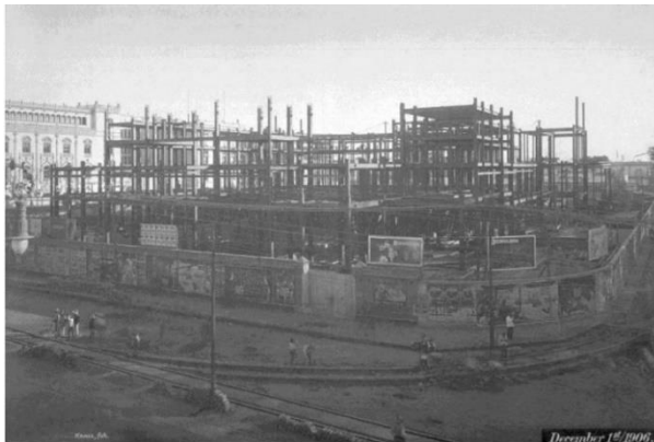
Montaje de la estructura de acero en la zona del estacionamiento del Nuevo Teatro Nacional. Fotografía de Guillermo Kahlo, 1906.
