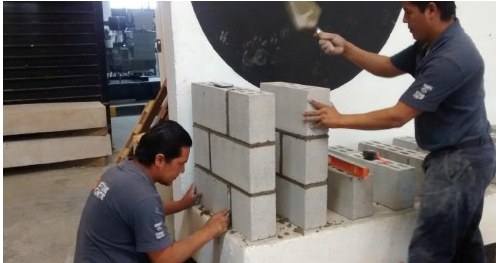
Fig. 2.10 Procedimiento constructivo de muretes de mampostería. 3
