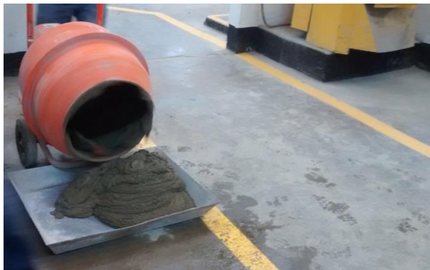
Fig. 1.9 Morteros instantáneos, estos ya vienen dosificados desde planta de producción; solo requieren agregar agua. 3
