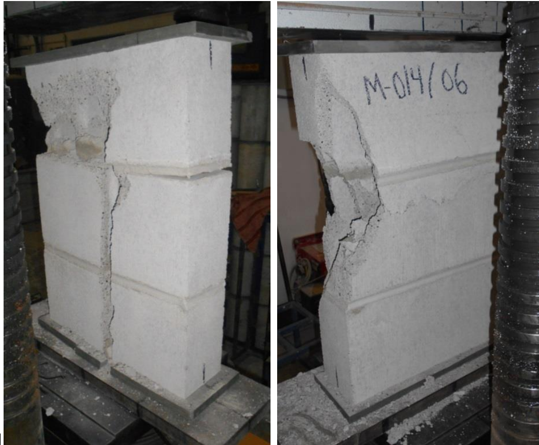
Fig. 2.5 Pilas después de la carga (se observan las fallas a través de las piezas). 3
