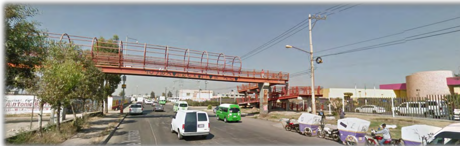
Ilustración 64 – Av. Bordo de X. – Vista Puente Peatonal Crit Teleton– Imagen Google Maps
