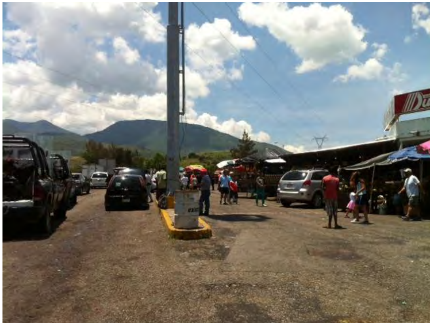
Ilustración 2. Accesos irregulares sin carriles de aceleración ni desaceleración en km. 287 Caseta Palo Blanco.
