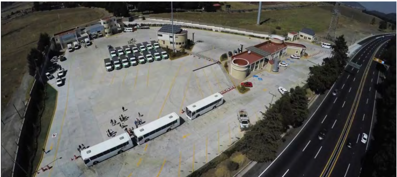
Ilustración 3. Parador Integral Parres Kilómetro 38+200 Autopista México-Cuernavaca.
