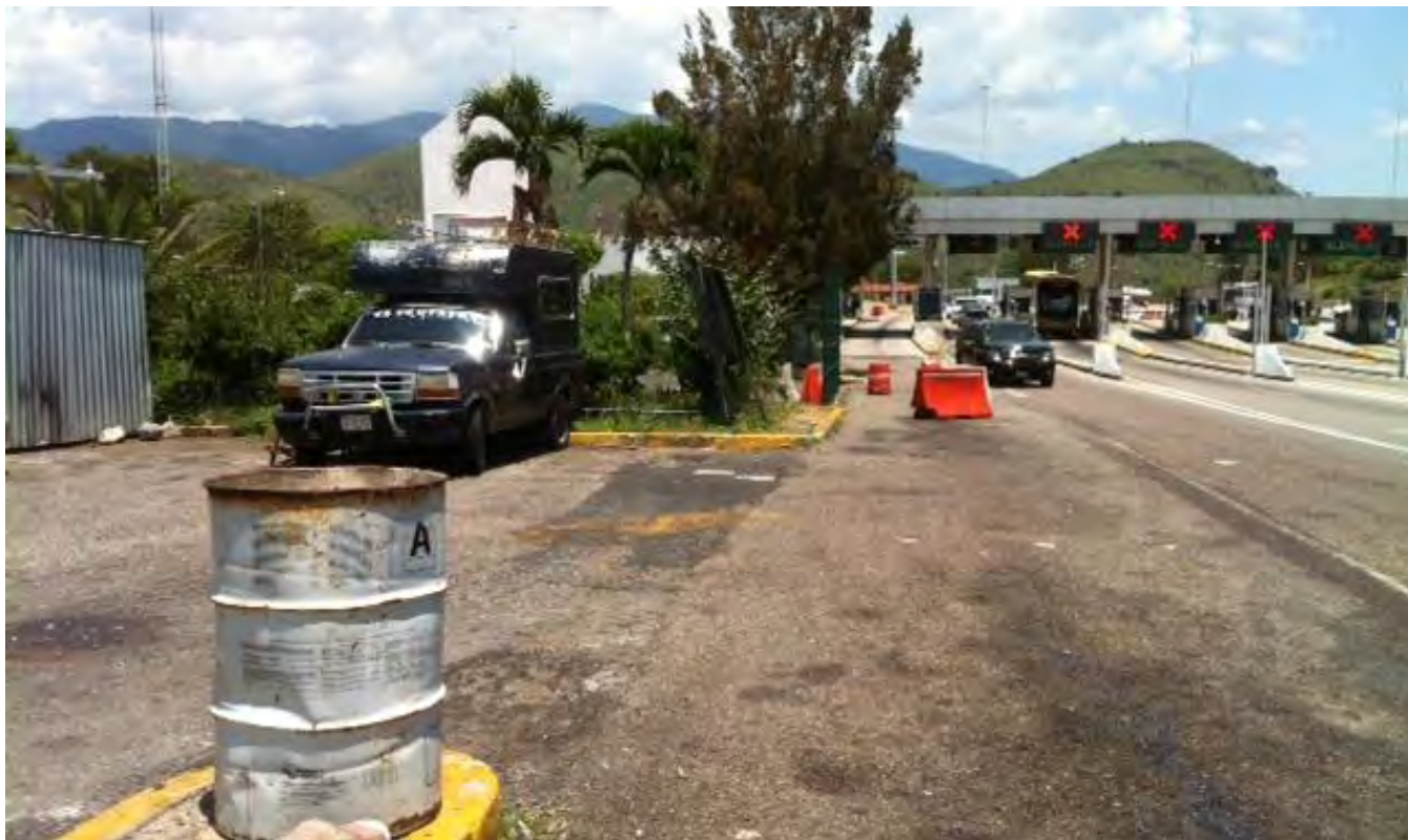
Ilustración 19. Accesos irregulares sin señalamiento adecuado en establecimiento, en el km. 287, Autopista del Sol, Caseta Palo Blanco.
