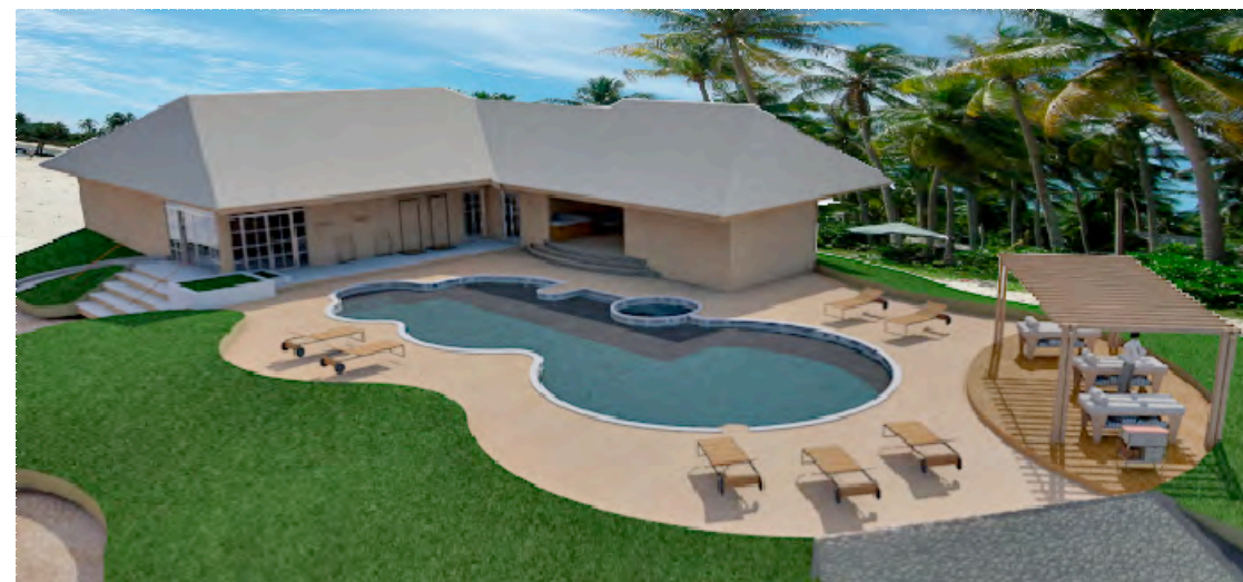
ESTRUCTURA A BASE DE MADERA, TECHO A 4 AGUAS Y CIMENTADA SOBRE UNA LOSA DE CIMENTACIÓN
