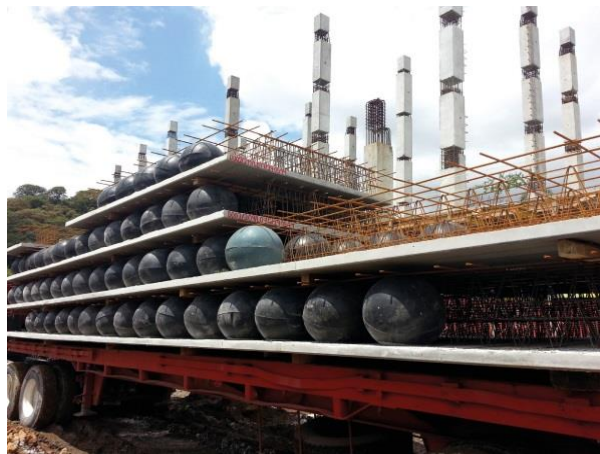
Fig. 3.1 Transportación de los paneles
