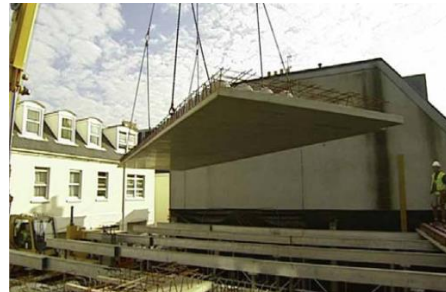
Fig. 3.3 Elevación del panel
