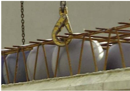
Fig. 3.2 Ubicación del gancho de izaje
