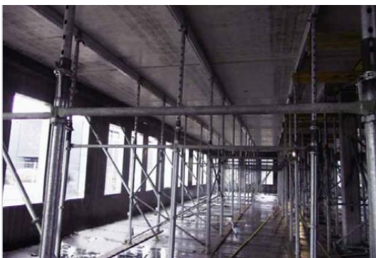
Fig. 3.5 Cimbrado de paneles
