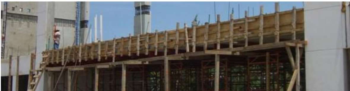
Fig. 3.11 Detalle del cimbrado perimetral del panel
