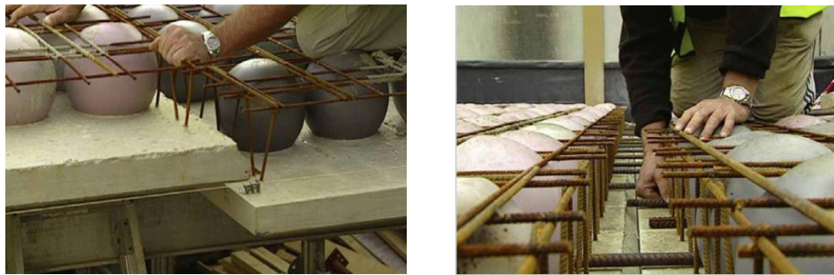
Fig. 3.9 Alineación de paneles y colocación de acero de conexión
