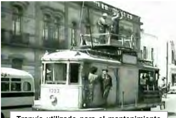
Tranvía utilizado para el mantenimiento de las líneas.
