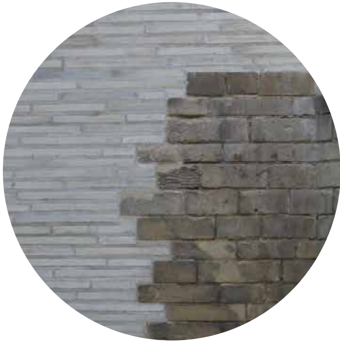
Detalle de unión entre pre existencia e intervención
