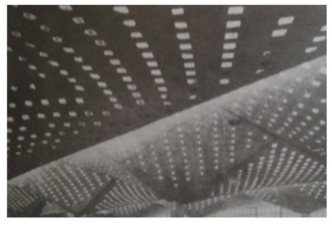
lmg. 52. Fábrica de trajes en Coyoacán, la estructura base consiste en paraguas formados por secciones de paraboloide hiperbólico, forma que les permite librar grandes claros con espesores mínimos de concreto. Arq. Félix Candela, 1958.
