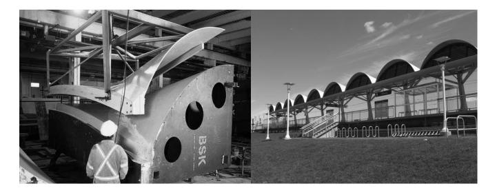
lmg. 44. A la izquierda, desencofrado de una de los 24 cascarones de concreto que forman la cubierta de la estación de trenes de Shawnessy.
