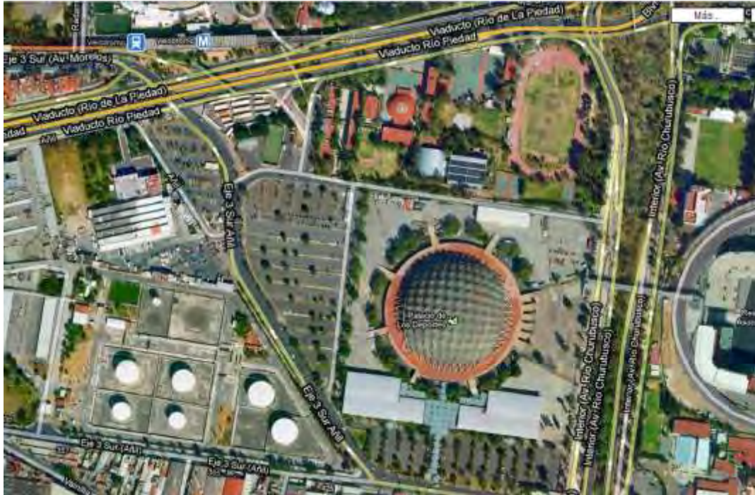
Figura 3.9. Terminal Satélite Añil.
