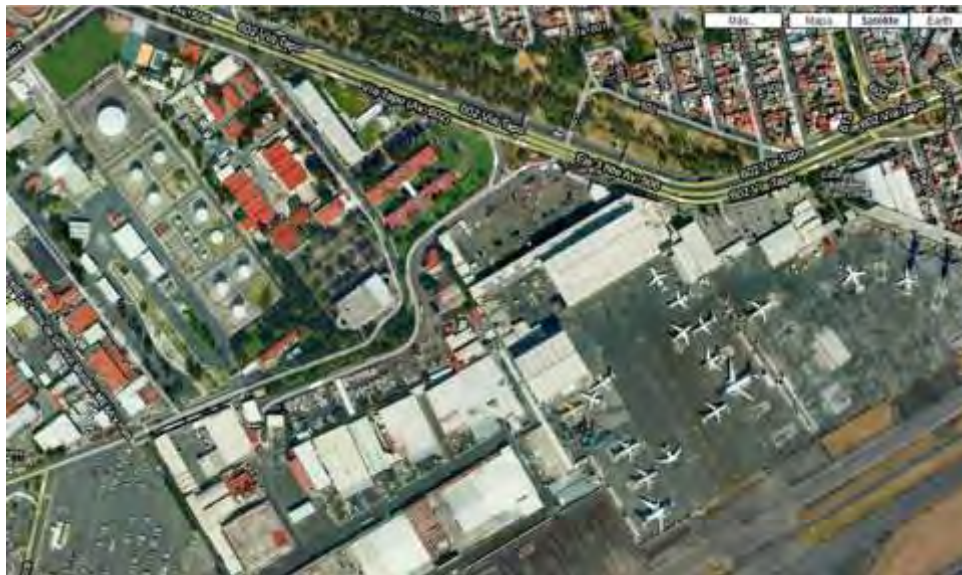
Figura 3.10. Almacenamiento de Combustible Aeropuerto.
