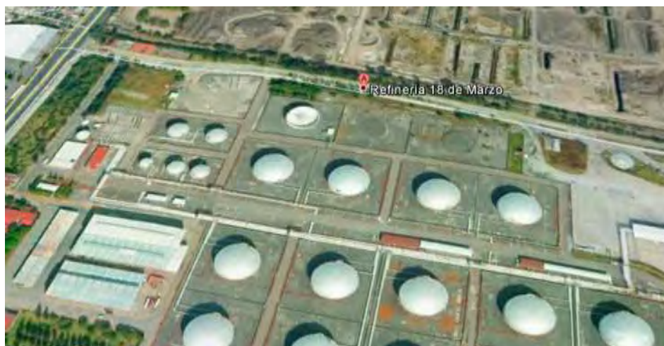
Figura 3.13. La Terminal de Almacenamiento y Distribución de Azcapotzalco
