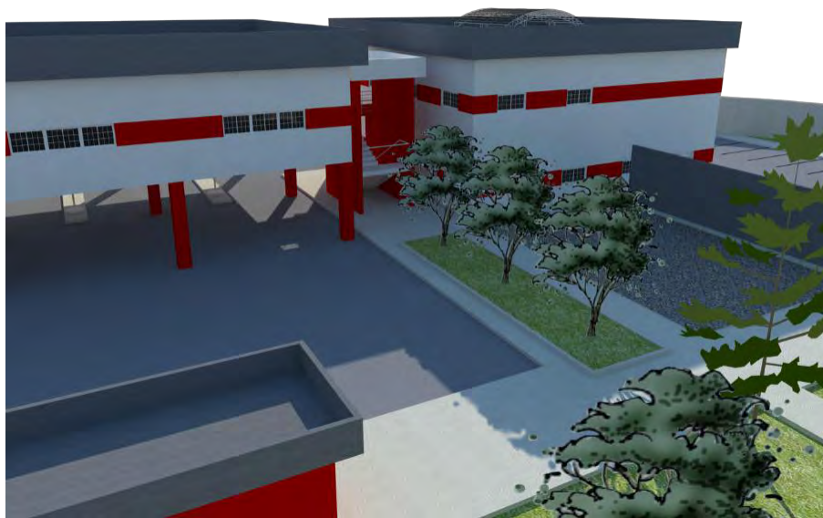
Ilustración 82 Vista desde la cancha
