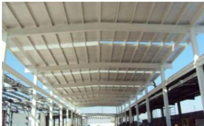
Figura 2.11. Cubierta plana (Mabasa, 2015)
