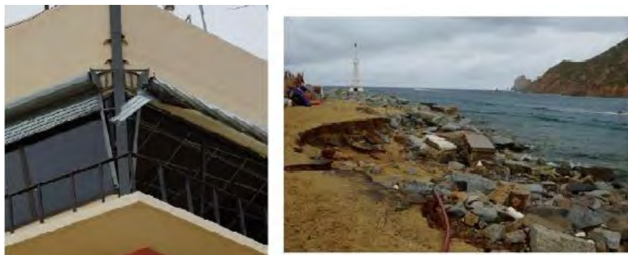
Figura 2.5. Daño en torre de control de los Cabos y en puerto Cabo San Lucas. (Murià, et al., 2016)
