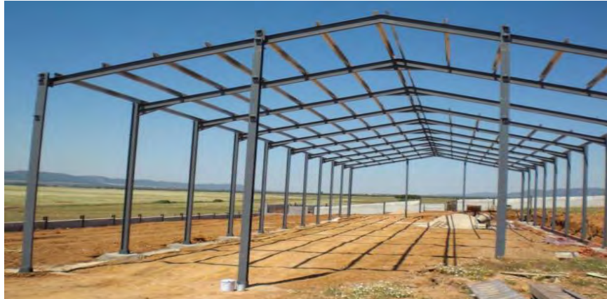
Figura 2.10. Nave Industrial metálica (Vizuete, 2013)
