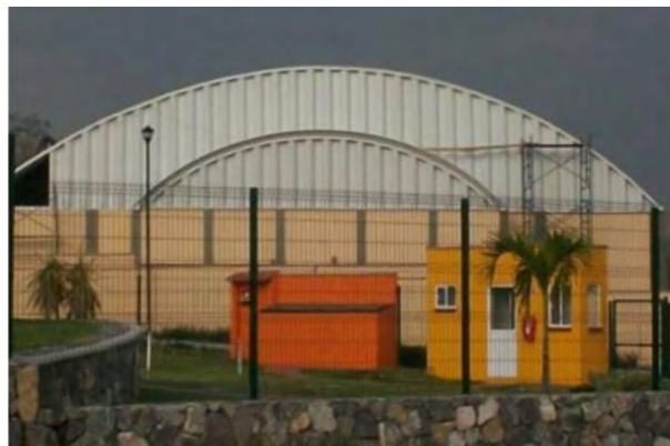
Figura 2.13. Nave industrial tipo arco.
